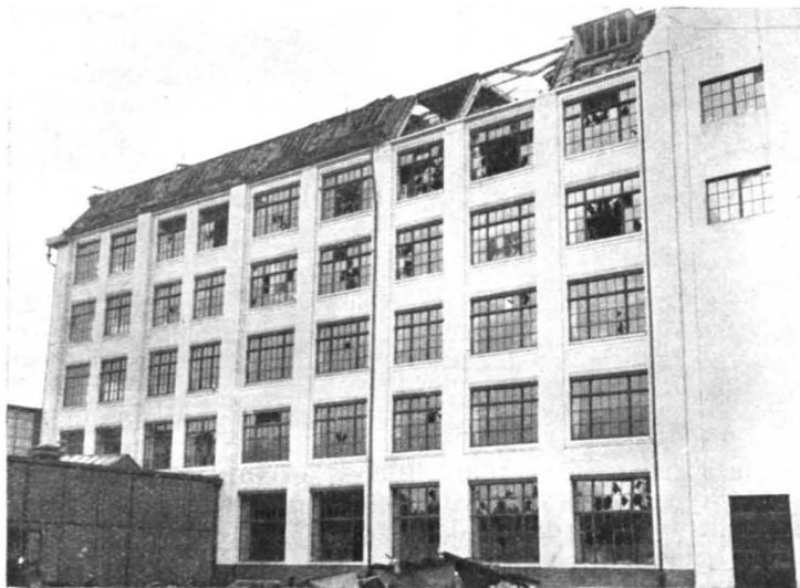
Abb. 1. Verhalten der Stahlkonstruktion und der Steineisendecken bei einer Explosion.
