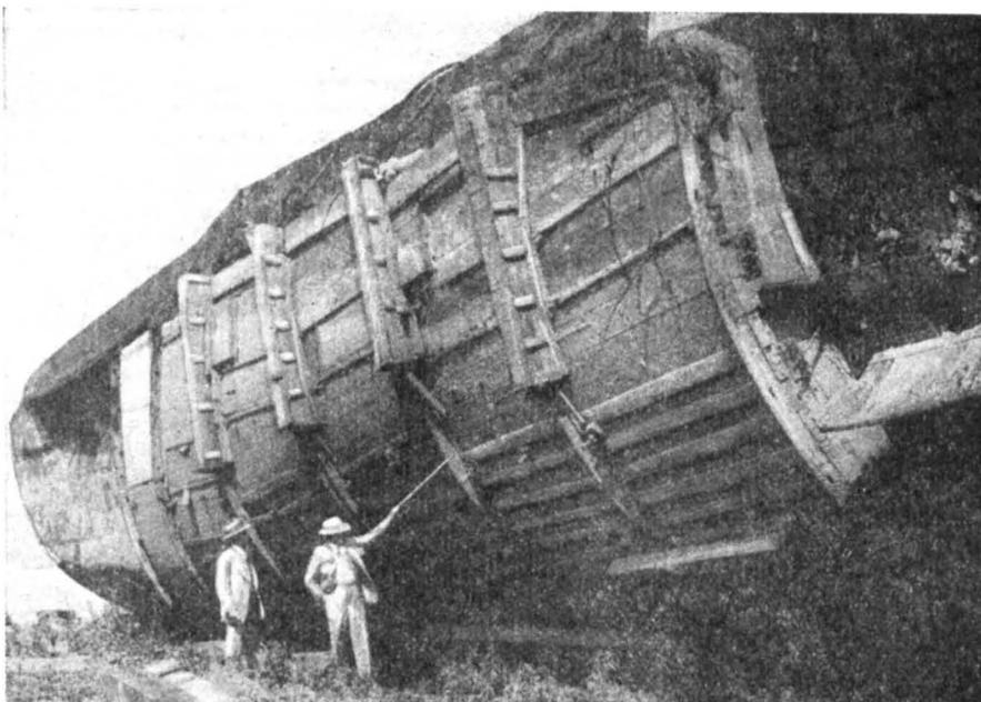
Das geflickte Loch im Boden des Hulks der A l a b a m a. Eine 900-kg-Bombe riß ein Loch von 14,40 m Länge und 8,40 m Breite.
