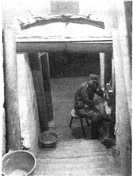
Bild 1. Gasschleuse mit Hausteleson.
