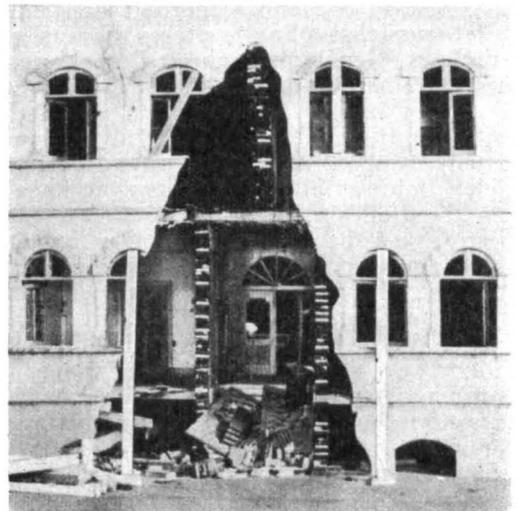
Bild 2. Abstützen freihängender Gebäudeteile.
