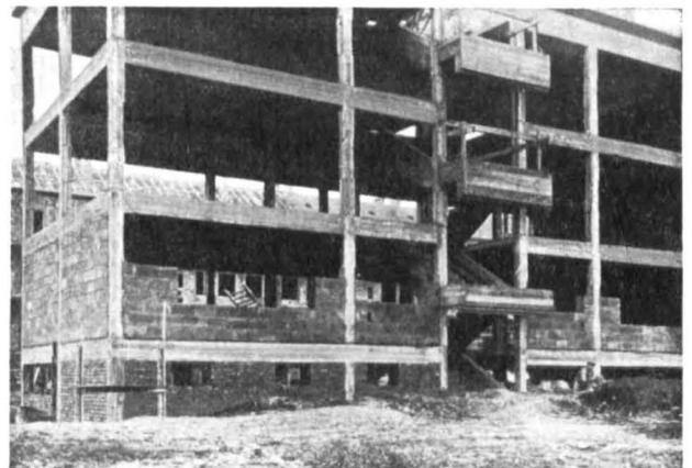
Bild 3. Wohnhaus als Skelettbau mit Leichtbetonausfachung.
