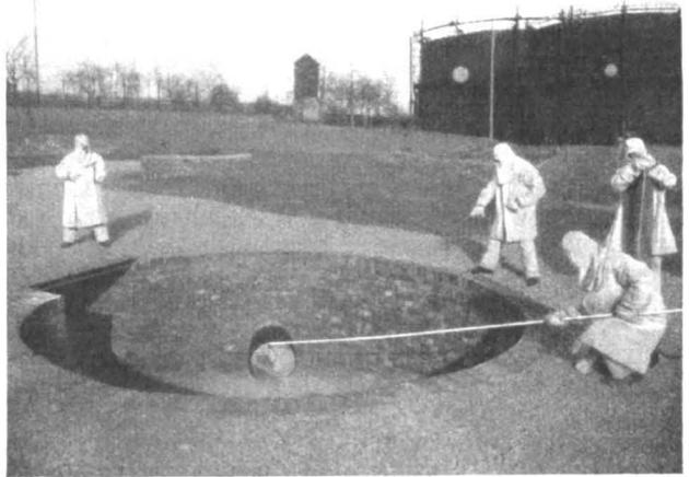
Bild 6. Aufgeblähter Asbestbeutel in der Rohróffnung.
