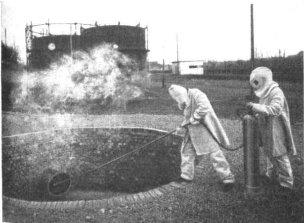
Bild 4. Brennende Öffnung einer 600-mm-LW.-Rohrleitung.
