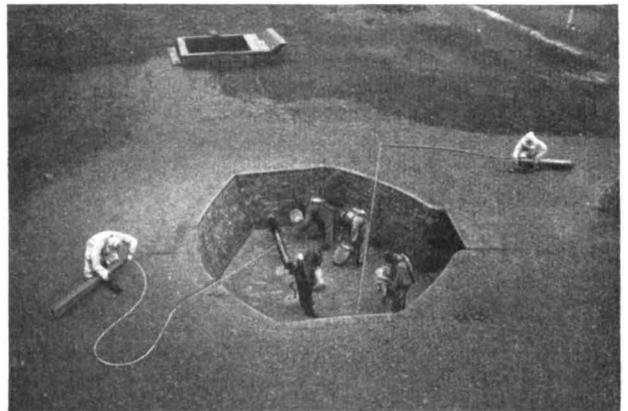
**Bild 3. Abdichten der Rohrleitung nach erfolgter Löschung (Rohrlichtweite 300 mm).**
