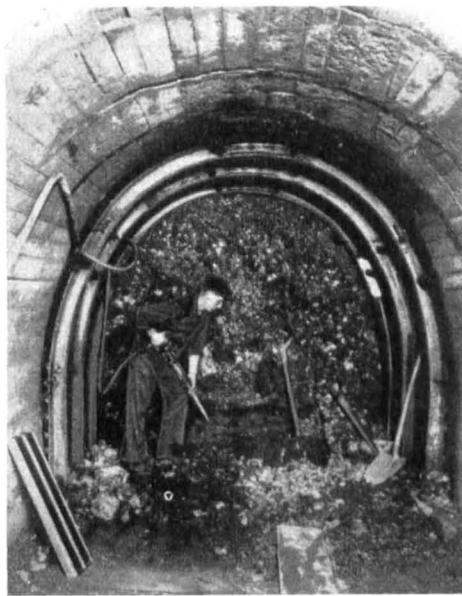
Bild 2. Vortrieb eines Stollens aus Pokaleisen.
