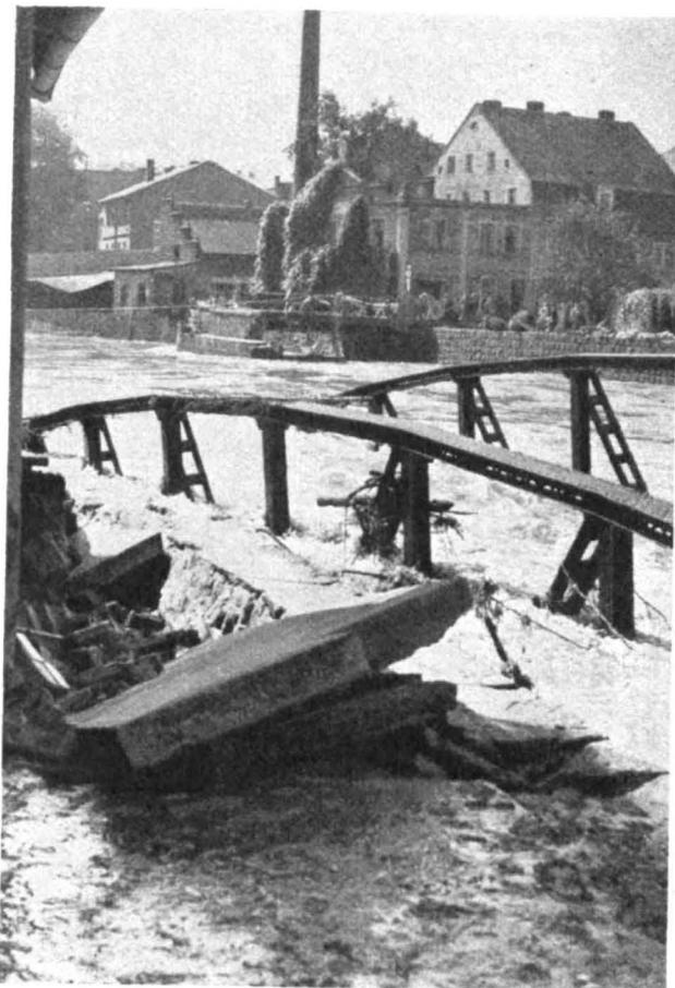
Bild 2. Die Neiße zerstörte durch ihre reißenden Wasser die Brückenfundamente und brachte selbst schwere eiserne Brücken zum Einsturz.
