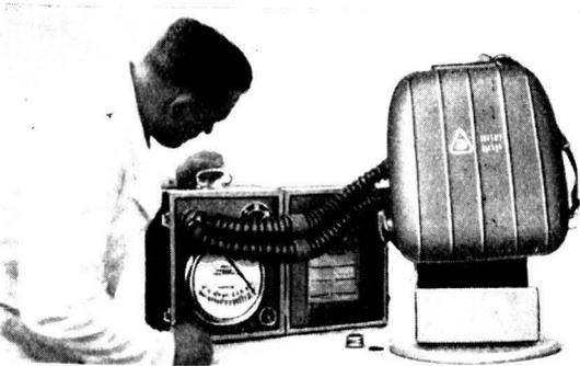
Bild 25. Zu Prüfungsvorgang 6: Beobachten des Messzeigers beim Prüfen des Heeresatmers auf Dichtigkeit.
