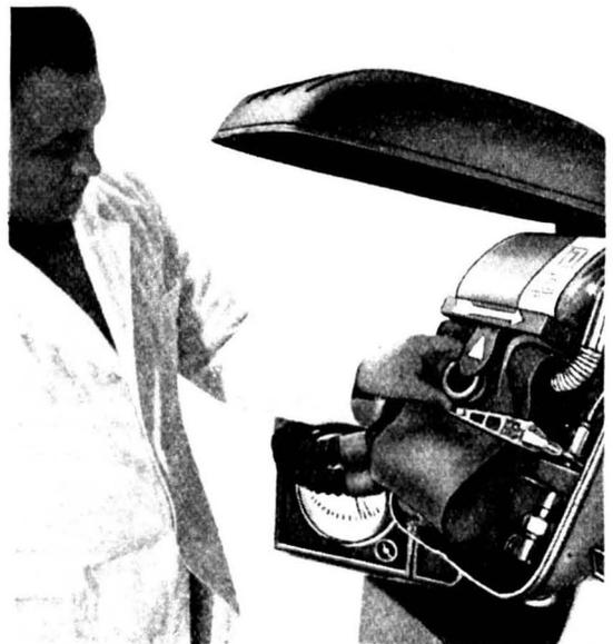
Bild 21. Zu Prüfungsvorgang 6: Durch Überstreifen des Prüfringes Überdruckventil blockieren.
