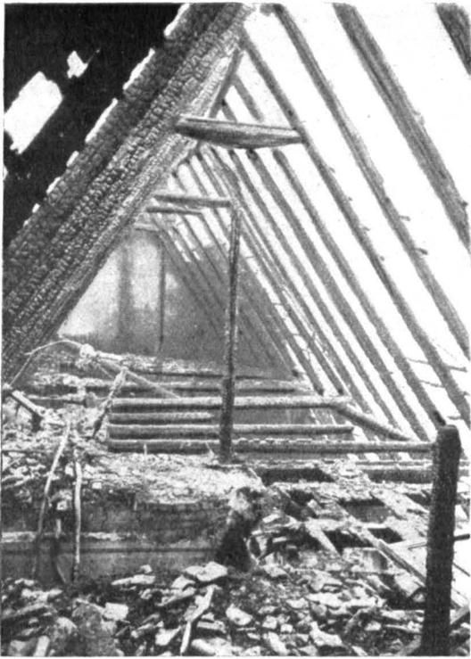
Bild 1. Dachgeschoß eines Wohnhauses, vom Feuer zerstört.
