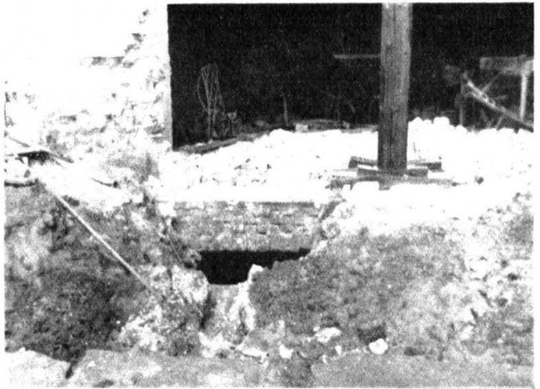
Sprengbombe direkt vor dem Hause eingeschlagen, Kellerdecke hat gehalten. Ein Tragepfeiler wurde eingedrückt und mußte durch Absteifung ersetzt werden.
