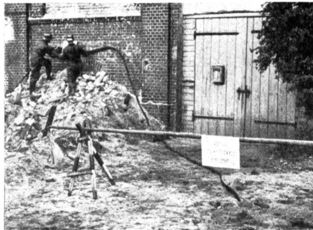
Bilder 1 und 2. Umgehung einer Schadenstelle im Luftschutz mittels Kabel.
