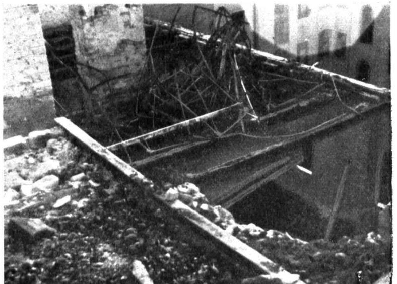
Der Dachboden war durch Maschendraht in Kammern unterteilt. Der Maschendraht hat sich bei der Brandbekämpfung als sehr hinderlich erwiesen.
