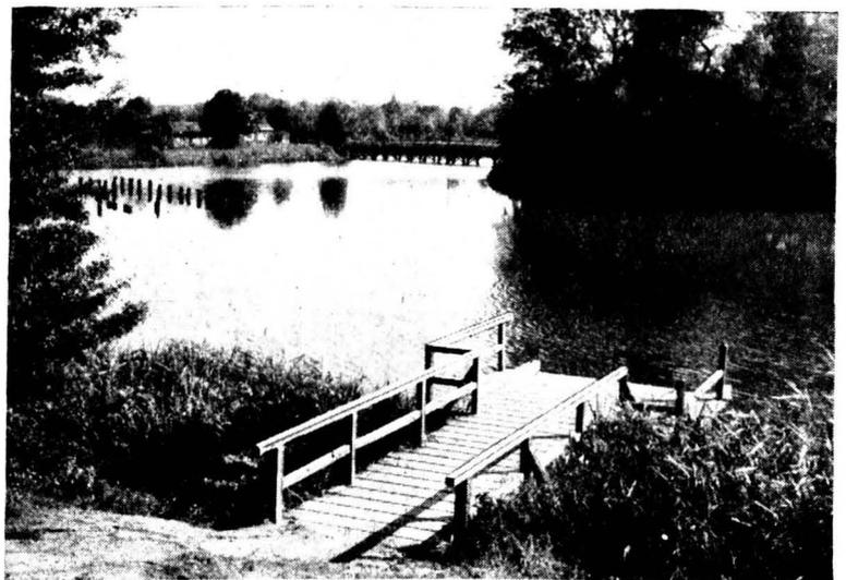
Bild 3. Podest aus Holz für Tragkraftspritze an nicht befahrbarem Ufer.
