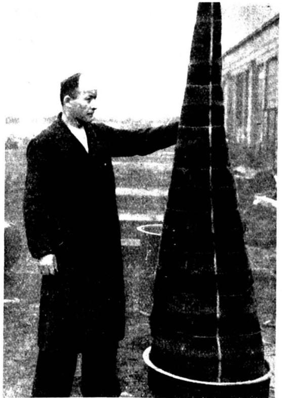
Bild 122. Das Schwebstoff-Filter von Bild 121 ungefalt, um die Größe der Oberfläche zu zeigen.
