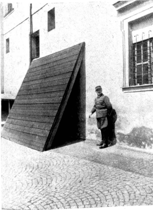
Bild 7 a. Ausführung zu Zeichnung 7: Trümmerschirm über einem tielliegenden Notauslaß (Kellerhals). Abdeckung mit 10 cm starken, aufgeschraubten Bohlen.
