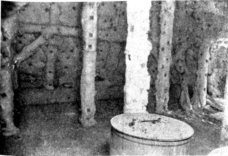
Bild 5. Blick auf einen durch Imprägnierung und Umkleidung aller Holzteile mit Glaswolle sowie durch Belegung der Bodenfläche mit Sand feuergeschützten Dachboden eines kleineren Forschungsinstitutes.
