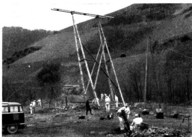
Aufrichten eines A-Portal-Behelfsmastes beim Freileitungs-Lehrgang
