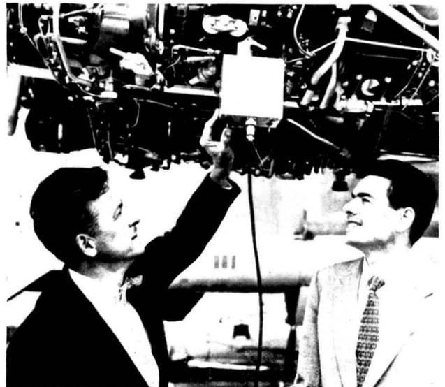
Ingenieure überprüfen das neuartige DüsenEinstellungsgerät, das unter dem Motor befestigt wird und vom Bordmechaniker vom Führerstand aus betätigt wird
