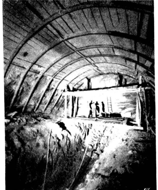
Bild 4 Kreuzliberg-Tunnelbau mit Stahlbögen
