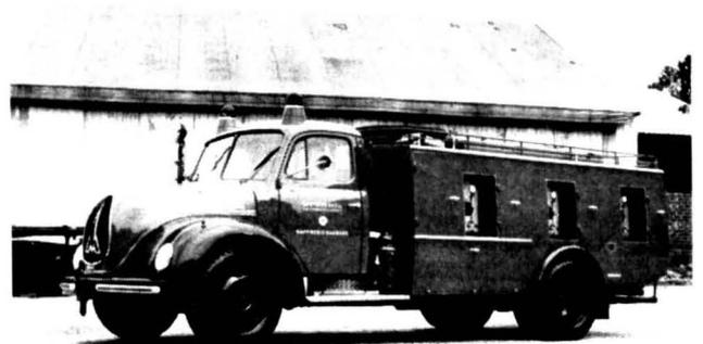
Abb. 14 Pulver-Löschfahrzeug (2250 kg)
