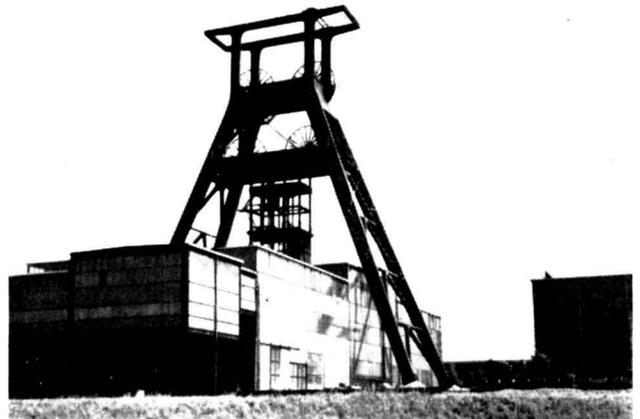
Bild 3 Fördergerüst in Stahlbauweise, Fördermaschine in seitlich liegendem Gebäude
