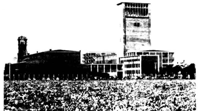
Bild 4 Förderturm in Stahlbetonbauweise, Fördermaschine im oberen Teil des Turmes
