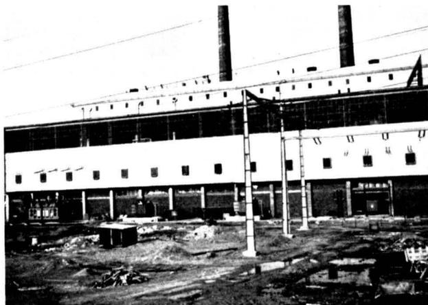
Bild 1 Süd-Ansicht des Kraftwerkes. — Blick auf das Maschinenhaus. Von + 0,00 bis + 7,50 m Betonwände mit Vormauerung: 500 kg/m<sup>2</sup> Staudruck, über + 7,50 m ausblasbare Konstruktion.
