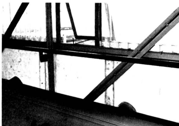
Bild 9 Bekohlungsanlage: Ansicht der Verkleidung der Schrägbrücken von innen. Aufbau der Wandverkleidung: außen: Well-Eternit, darüber Plexiglas, innen: Glatt-Eternit bis Höhe Plexiglas.
