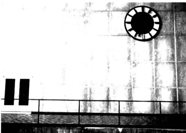
Bild 7 Innenansicht der Verkleidung der Giebelwand des Maschinenhauses. — Verkleidung in ausblasbarer Konstruktion.
