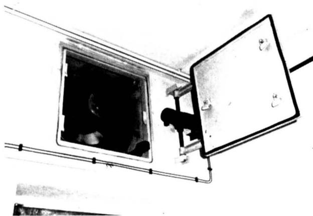
Bild 10 Schaltheis: Ansaugöffnung für künstliche Belüftung in der Außenwand mit Stahlblende mit Druckluftantrieb.
