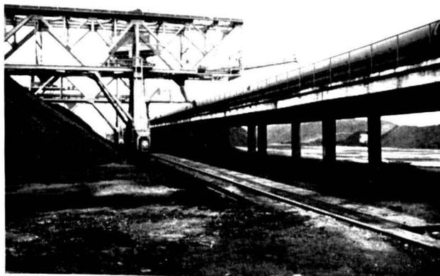
Bild 5 Bekohlungsanlage: Hochbahn der Platzbekohlungs. Betonkonstruktion berechnet für  $500 \text{ kg/m}^2$  Staudruck.
