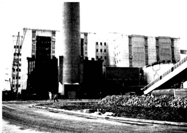
Bild 2 Nord-Ansicht des Kraftwerkes. — Blick auf die Kesselhäuser, Elektrofilter, Schornstein sowie Schalthaus. Kesselhäuser: ausblasbare Konstruktion. Kesselrückwand: berechnet und ausgeführt für einen Staudruck von 500 kg/m<sup>2</sup>.
