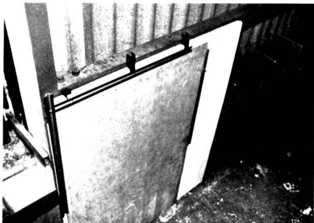
Bild 6 Maschinenhaus Außenwand über + 9,00 m. — Aufbau der Wandverkleidung: außen: Well-Eternit, innen: Isolierplatten, abgedeckt mit Glatt-Eternit, Fugen-Abdeckung durch Alu-Schienen.
