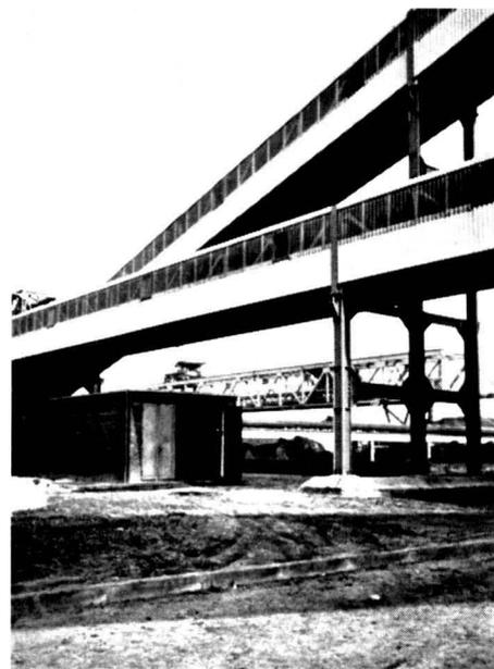
Bild 4 Bekohlungsanlage: Schrägbrücken. — An den Stützen Vorrichtungen zum Befestigen der Abspannseile. Links am Bildrand ein Betonfundament für die bodenseitige Befestigung der Abspannung.
