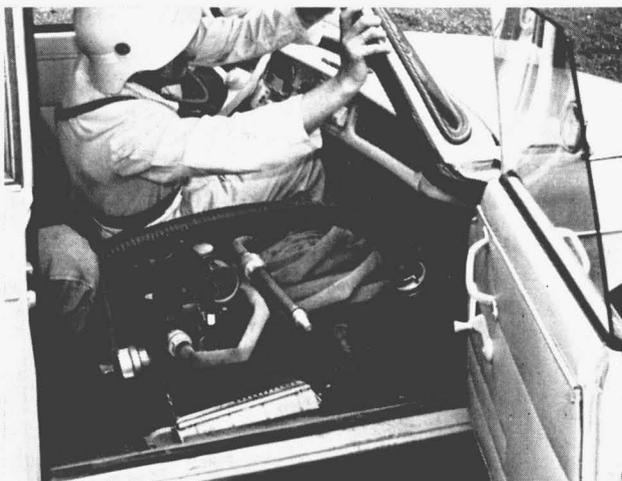
Bild 1 Motorisierter Brandschutztrupp des erweiterten Selbstschutzes. Anstelle des entfernten Beifahrersitzes ist die TS 0,5 nebst einem Flexi-Wassertank von 50 l untergebracht.
