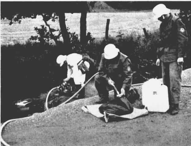
Bild 3 Füllstation für den Löschwassernachschub im Pendelverkehr mit einer TS 0,5 an einem Bach. Mit der TS 2,5 geht das Füllen natürlich schneller.
