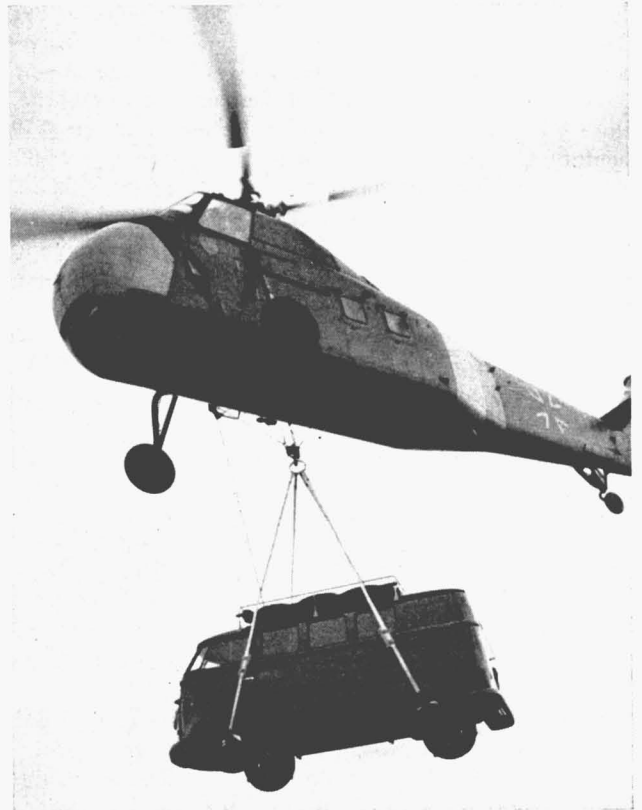
Abb. 1: Mittlerer Hubschrauber mit VW-Bus und eingebautem Wasserfiltergerät von etwa 1700 kg Gewicht am Spezialheißgeschirr bei einer Katastrophenübung in Niedersachsen. Werksfoto Berkpfeld
