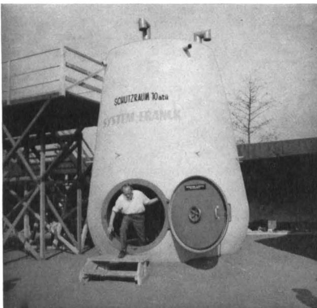
Bild 5: So sieht der fertige Schutzraum aus, der, nach Angaben der Firma, in die Erde eingelassen, eine Druckresistenz bis zu 10 atü aufweist.
