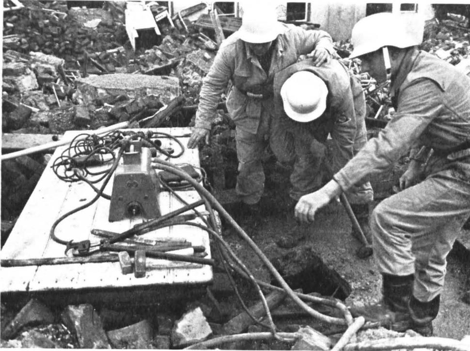
Der Durchbruch durch stahlarmierte Betondecken zählt zu den schwierigsten Arbeiten im Bergungsdienst. Mit Elektrohammer und Handwerkzeug schaffen die THW-Helfer das dennoch in kürzester Zeit.
