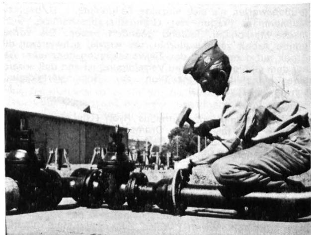
Szene aus dem THW-Lehrfilm „Rohr-Gas-Wasser“. Anschlagen einer Schraubmuffenkupplung nach Herstellen der Anbohrung einer Wasserleitung.
