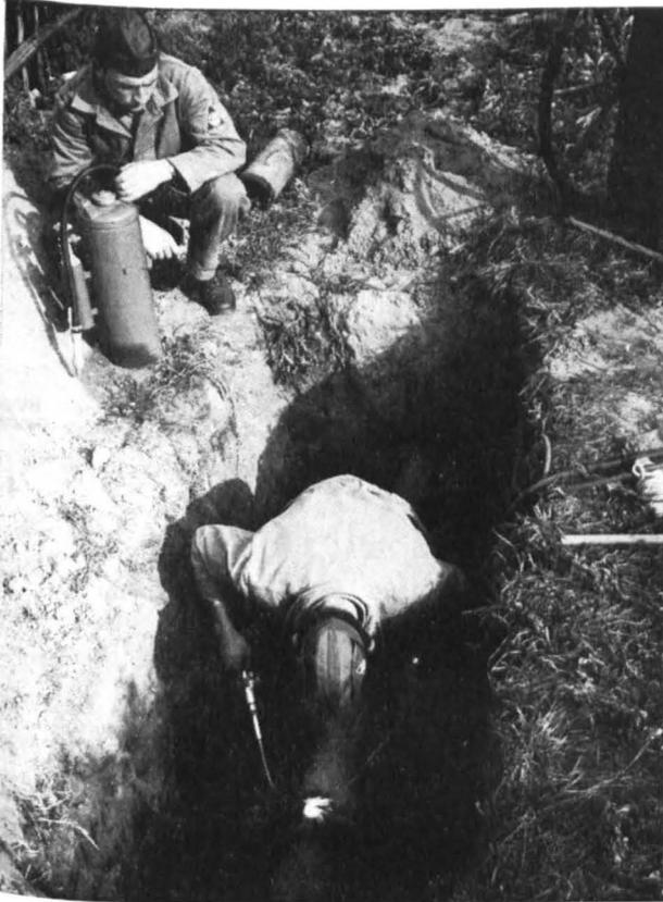
Szene aus dem THW Lehrfilm „Rohr-Gas-Wasser“. Ein Gasrohr wird nach Absperrung durch einen Luftball geschweißt. Ein Sicherheitsposten mit Feuerlöscher muß bereitstehen. Foto: Heinz W. Sütterlin
