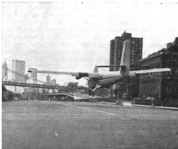
Ein schwieriger Landeplatz für große STOL-Flugzeuge wie diese zweimotorige DHC „Twin Otter“ war die South Street zwischen der Manhattan- und der Williamsburgbrücke, flankiert von Lagerhäusern und einer Schnellstraße. Unter dem rechten Flügel ist am Boden eine Landehilfe sichtbar, bestehend aus Richtscheinwerfer und Blende.
