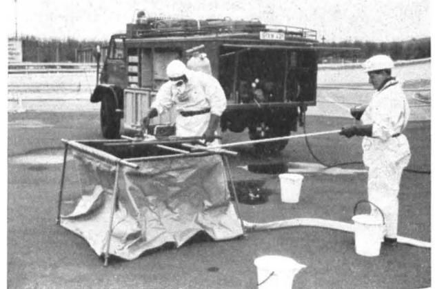
**Abb. 9:** Die Mannschaft bei Entstrahlung von Kleingerät am 1600-Liter-Faltbehälter. Der Helfer am Faltbehälter sprüht das Dekontaminationsmittel auf und führt gleichzeitig die Bürstenarbeit durch. Das Entstrahlungsergebnis wird mittels der Stocksonde überwacht. Das Spritzwasser läuft über den Faltbehälter durch eine Schlauchleitung in eine Sickergrube ab.
