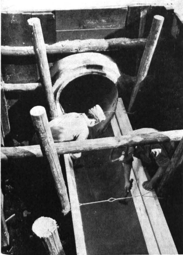
THW-Helfer haben eine Schadensstelle aufgegraben und ersetzen die zerbrochenen Rohre provisorisch durch eine Rinne aus Holz und Teerpappe. Foto: H. G. Seis
