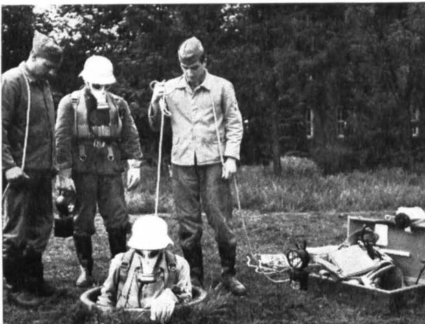
Sicherheit ist das oberste Gebot, wenn es um Arbeiten im Kanalnetz geht. Hier wird der Einstieg unter Atemschutz mit Anleinen, Sicherheitsposten und explosionsgeschützten Lampen gezeigt.
