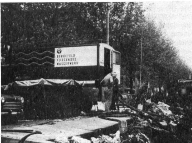
Bild 1: Bewegliche Wasseraufbereitungsanlage, Fabrikat Berkefeld, von 50 000 l Stundenleistung, auf der Uferböschung des Arno in Florenz im Einsatz. Davor abgedeckte Reinwasserbehälter.
