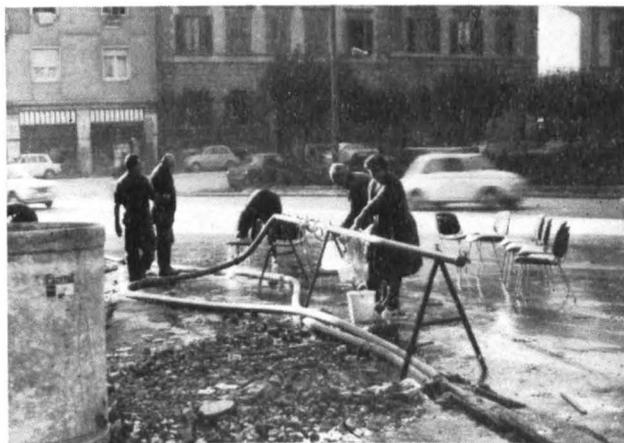
Bild 3: Notwasserversorgung in Florenz. Von der beweglichen Aufbereitungsanlage wurde das Reinwasser durch eine provisorische Leitung in die Stadt geführt. In Abständen wurden diese Gestelle mit Entnahmehähnen aufgestellt.
