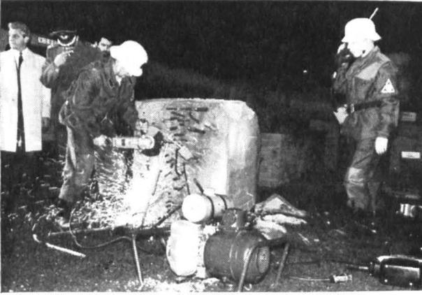
Unter den vielseitig verwendbaren Geräten der THW-Bergungsfahrzeuge befindet sich u. a. dieser Elektro-Trennschleifer für Betrieb durch Notstromaggregat.
