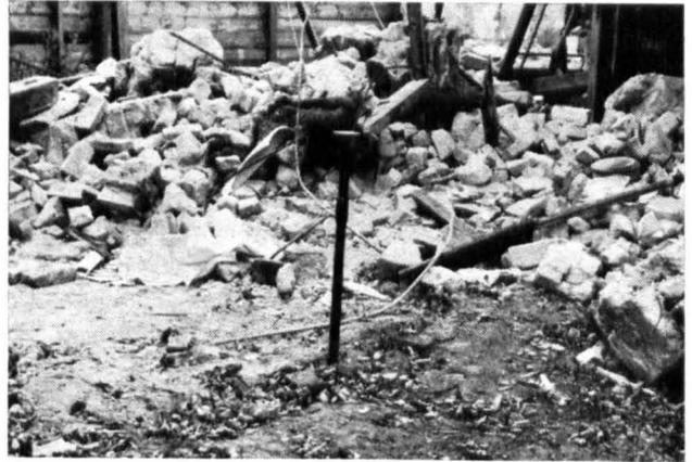
Abb. 7: Versuch der Anwendung von Eisenstangen als Schalleiter bis zum Boden der elektronischen Horchdose.
