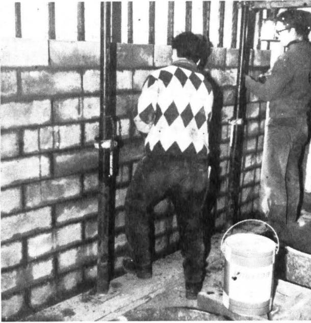
Es ist deutlich zu sehen, wie vorteilhaft die Dreiecksform des Steines zu verwenden war. Die senkrechte Bewehrung mußte nicht — wie bei anderen Konstruktionen — mühsam durch Öffnungen im Stein „aufgefädelt“ werden. Sehr rasch konnte die Mauer hochgezogen und mit der von oben kommenden Bewehrung verbunden werden. Als man die Wandhöhe erreicht hatte, wurde die Decke auf ein vorbereitetes Mörtelbett abgesetzt und so der dichte Anschluß hergestellt.
