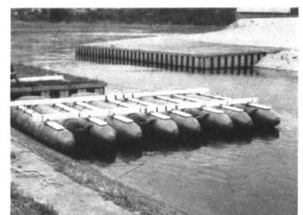
In der weiteren Stufe werden die Boote durch die Tragbalken verbunden.
