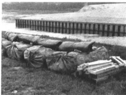
Packsäcke und Hölzer für den Bau einer Fähre auf Schlauchbooten.
