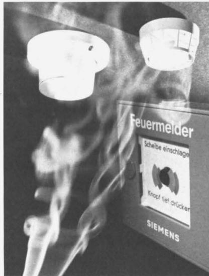
**Bild 1** Diese elektronischen Brandwächter sind rund um die Uhr im Einsatz. Links ein Ionisations-Rauchmelder, rechts ein Wärmedifferentialmelder. (Bild: Siemens)
