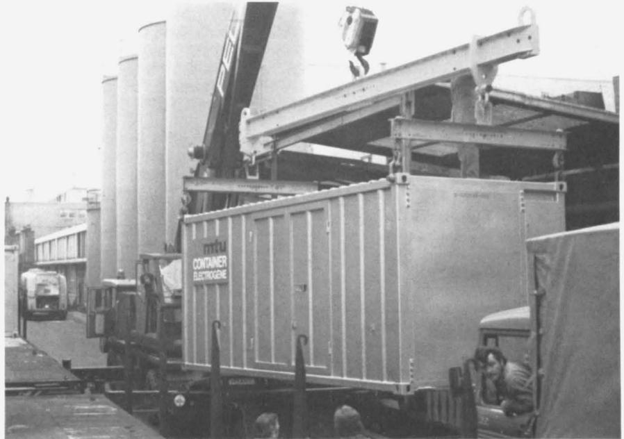
**Bild 5:** Durch den Einbau in Normcontainer läßt sich das mobile Kleinkraftwerk problemlos mit allen üblichen Verladeeinrichtungen auf alle gebräuchlichen Transportmittel verladen. (Bild: MTU)
