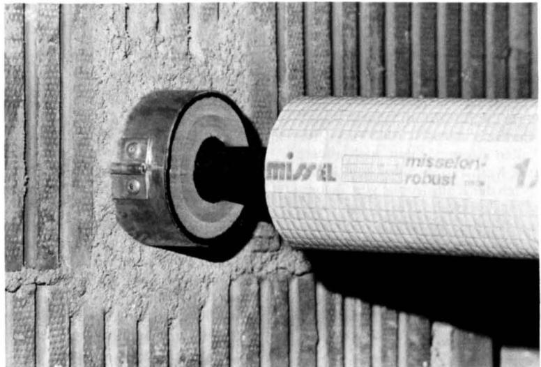
Die in den gängigen Dimensionen von 18 bis 42 mm Rohraußendurchmesser erhältliche Brandschutzdämmmanschette dient in erster Linie zur Abschottung einzelner Brandabschnitte, wenn Feuer ausbricht.
