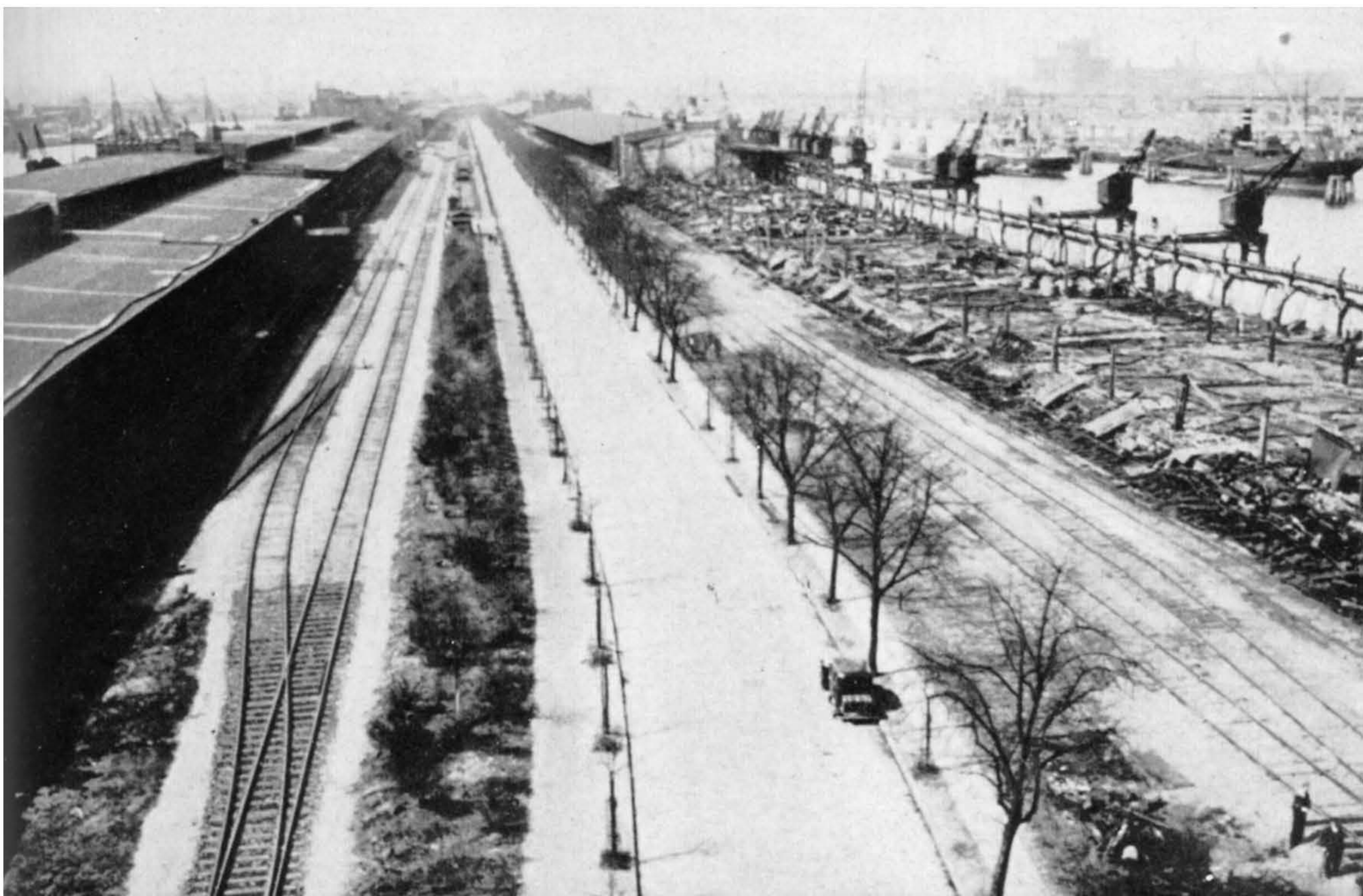
Lagerschuppenbrände. Der Schuppen rechts im Bild mit etwa 300 m Länge ist vollständig niedergebrannt, weil jegliche Unterteilung fehlte. Von dem linken Schuppen ist nur ein Teil ausgebrannt. Der Schuppen hatte mehrfach eine gute Brandmauerunterteilung.
