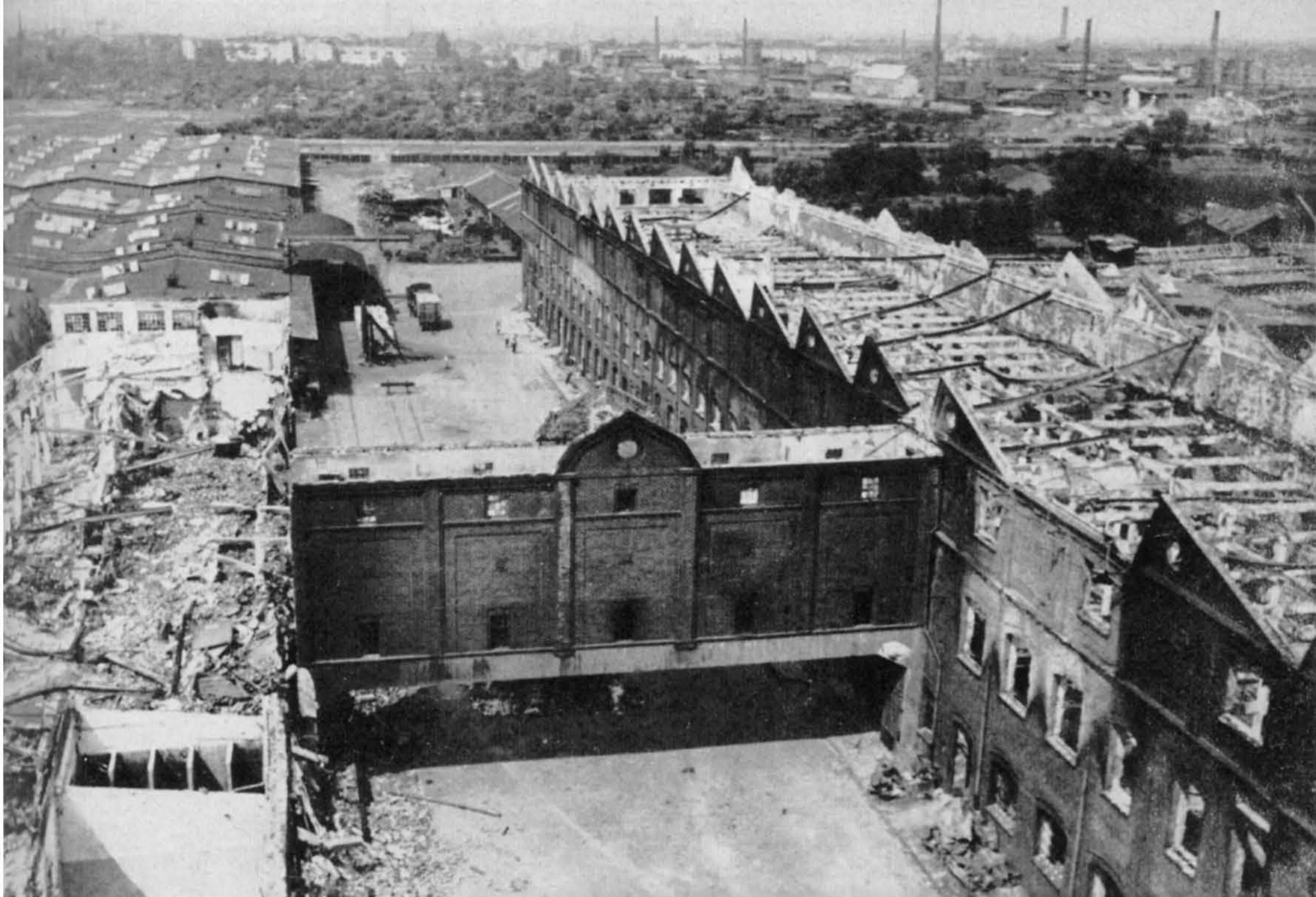
Doppelstöckige ‚Feuerbrücke‘ in einem Wollkämmereibetrieb. Infolge unzulänglicher Abtrennung der Übergänge in beiden Stockwerken ist es zu der Feuerübertragung gekommen, obwohl bei der breiten Fahrstraße sonst ein Überspringen des Brandes kaum zu befürchten wäre.
