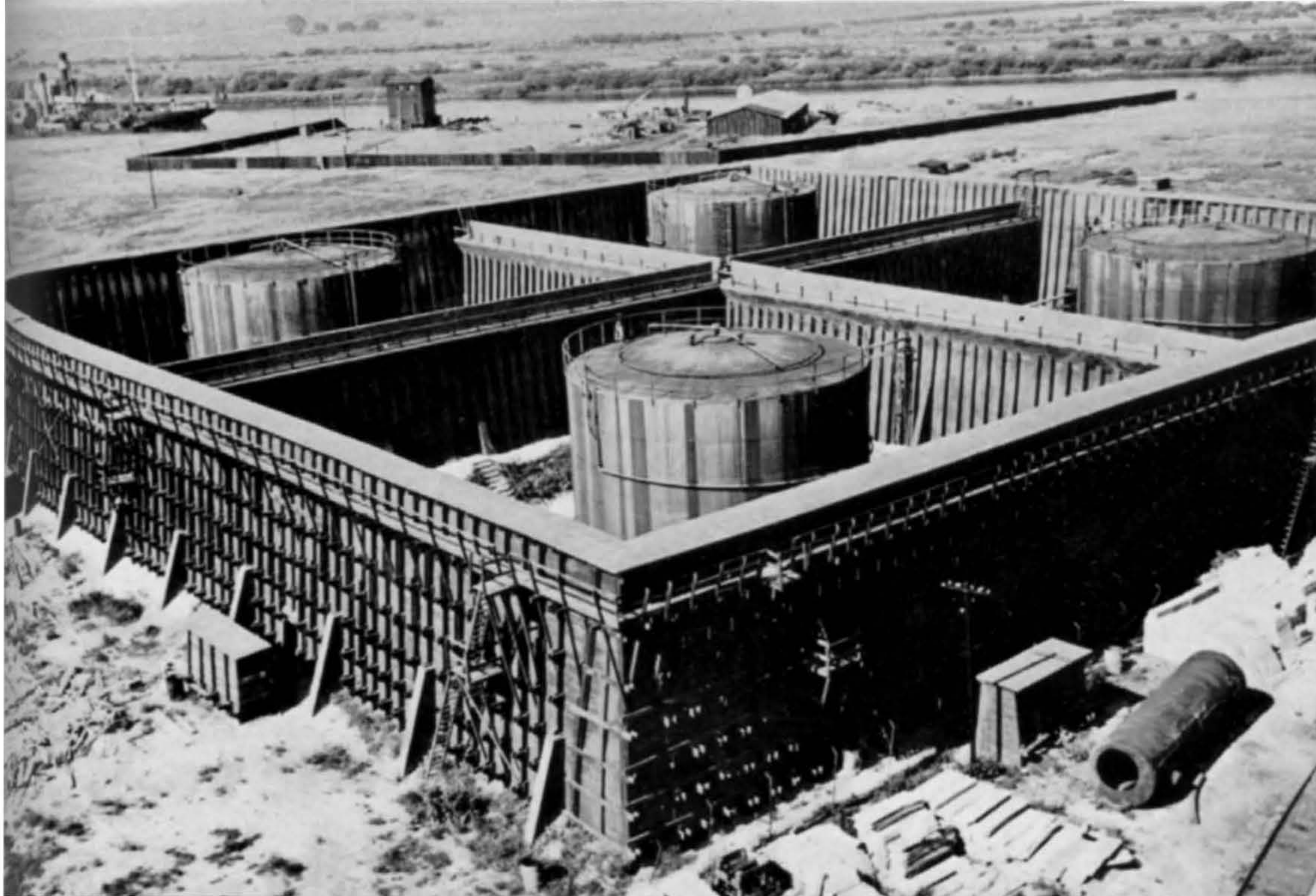
Vorbildlich geschützte Benzintanklager. Tanks einzeln in Gruben, Abstände untereinander über 2 Tankdurchmesser, Splitterschutzwände hochgezogen bis zum Tankdach.
