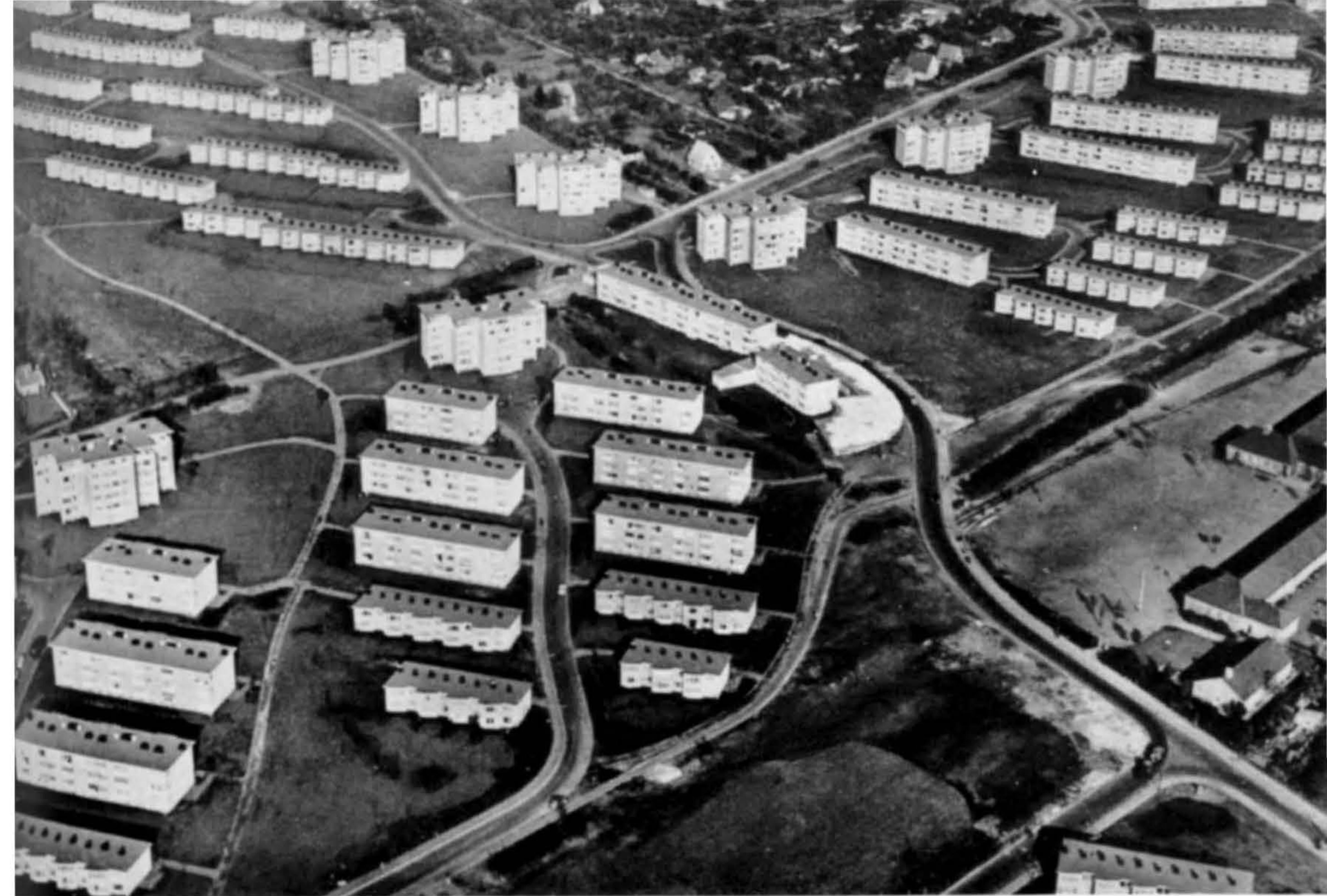
Die neue Siedlung ‚Hohnerkamp‘ in Hamburg 1957. Weit auseinander gezogene Häuserblocks mit Grünflächen, Feuerübertragung von einem auf den anderen Block selbst bei ungünstigen Verhältnissen kaum zu erwarten.
