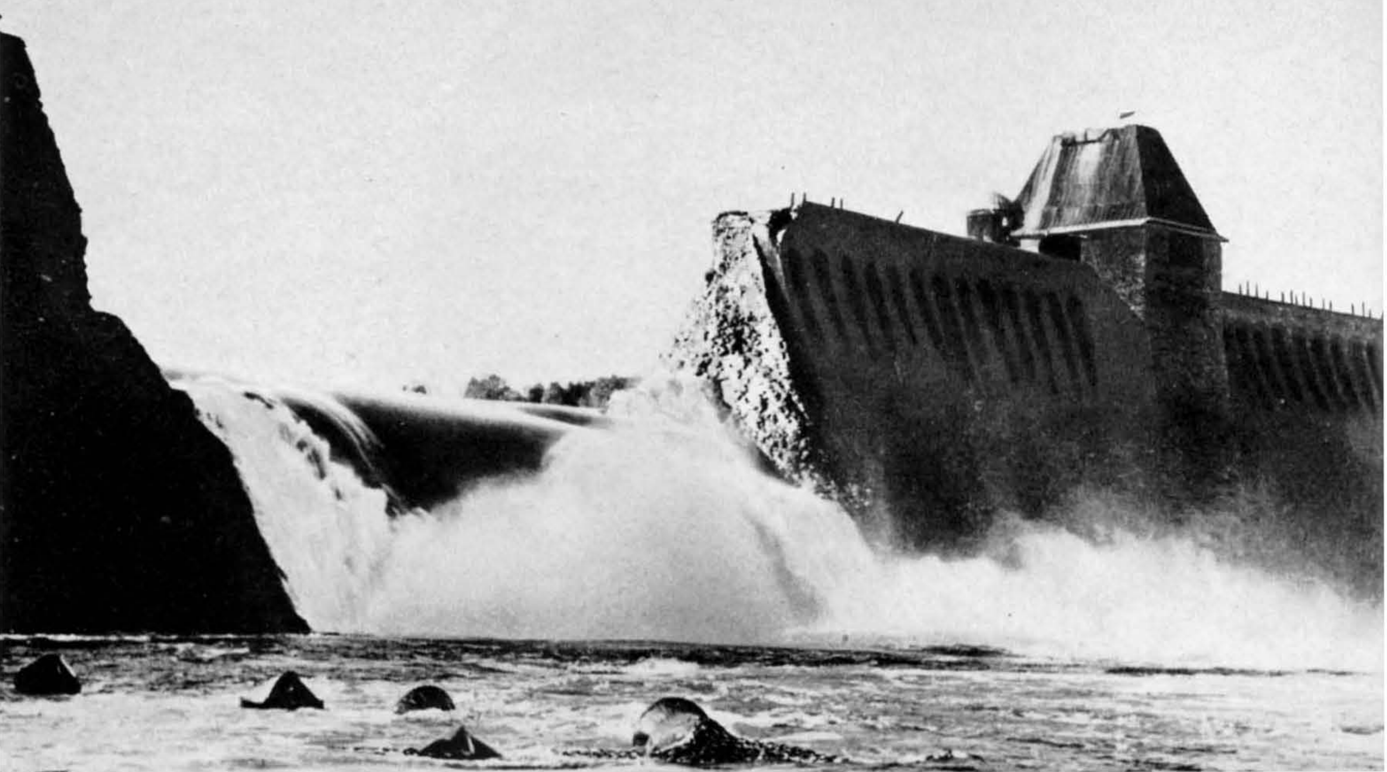
Die Bruchstelle an der Staumauer der Möhnetalsperre.
