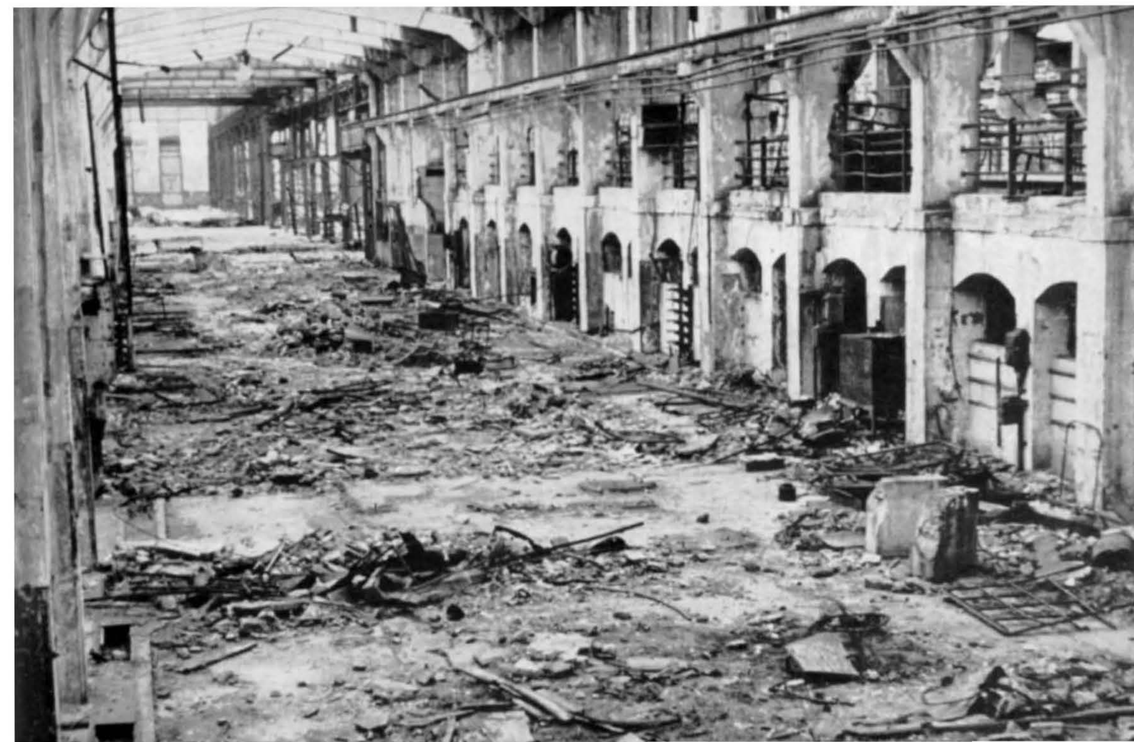
Typisches Bild einer zerstörten Werksanlage
