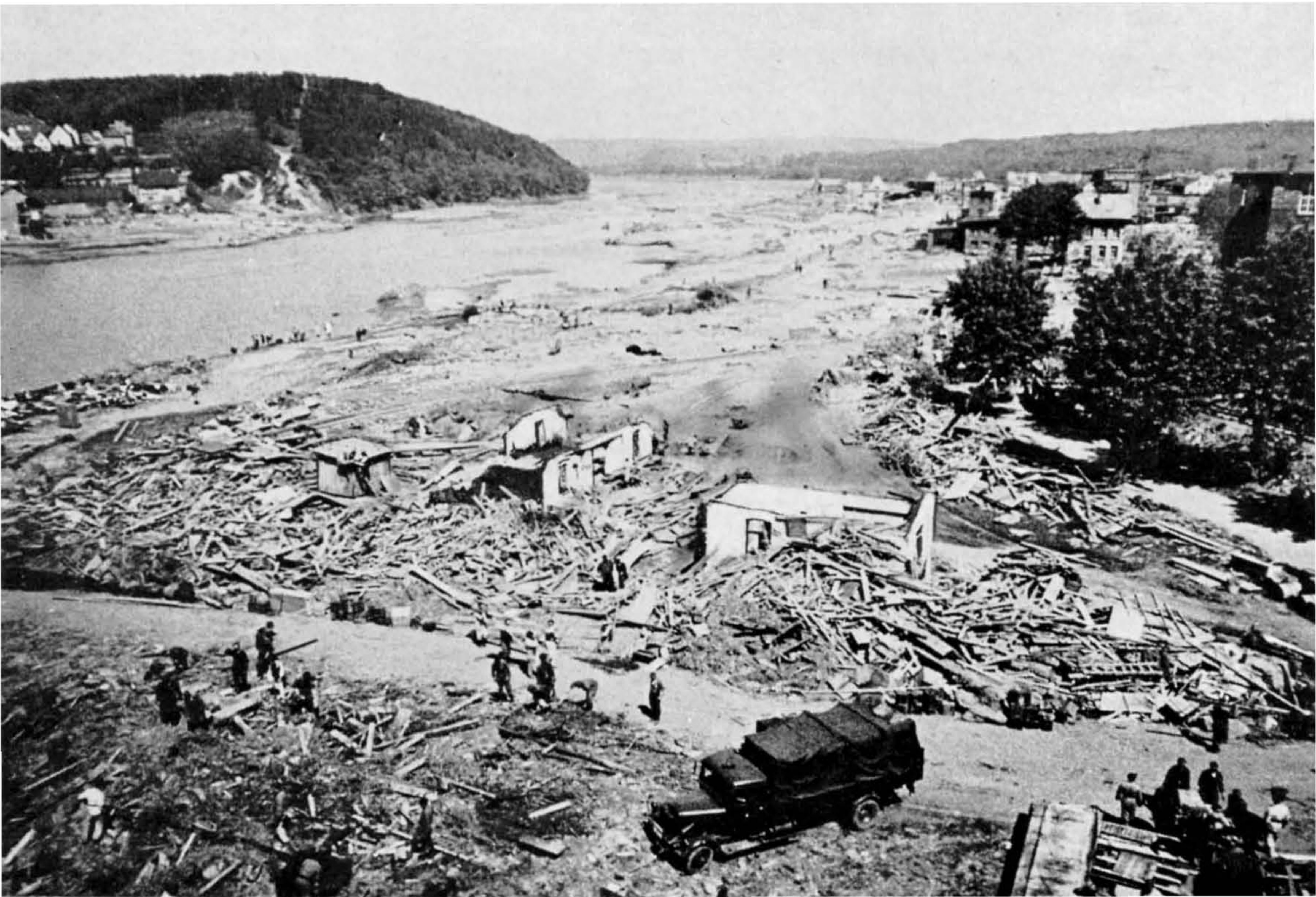
Die Verwüstung durch die Flutwelle nach Bruch der Staumauer der Möhnetalsperre.
