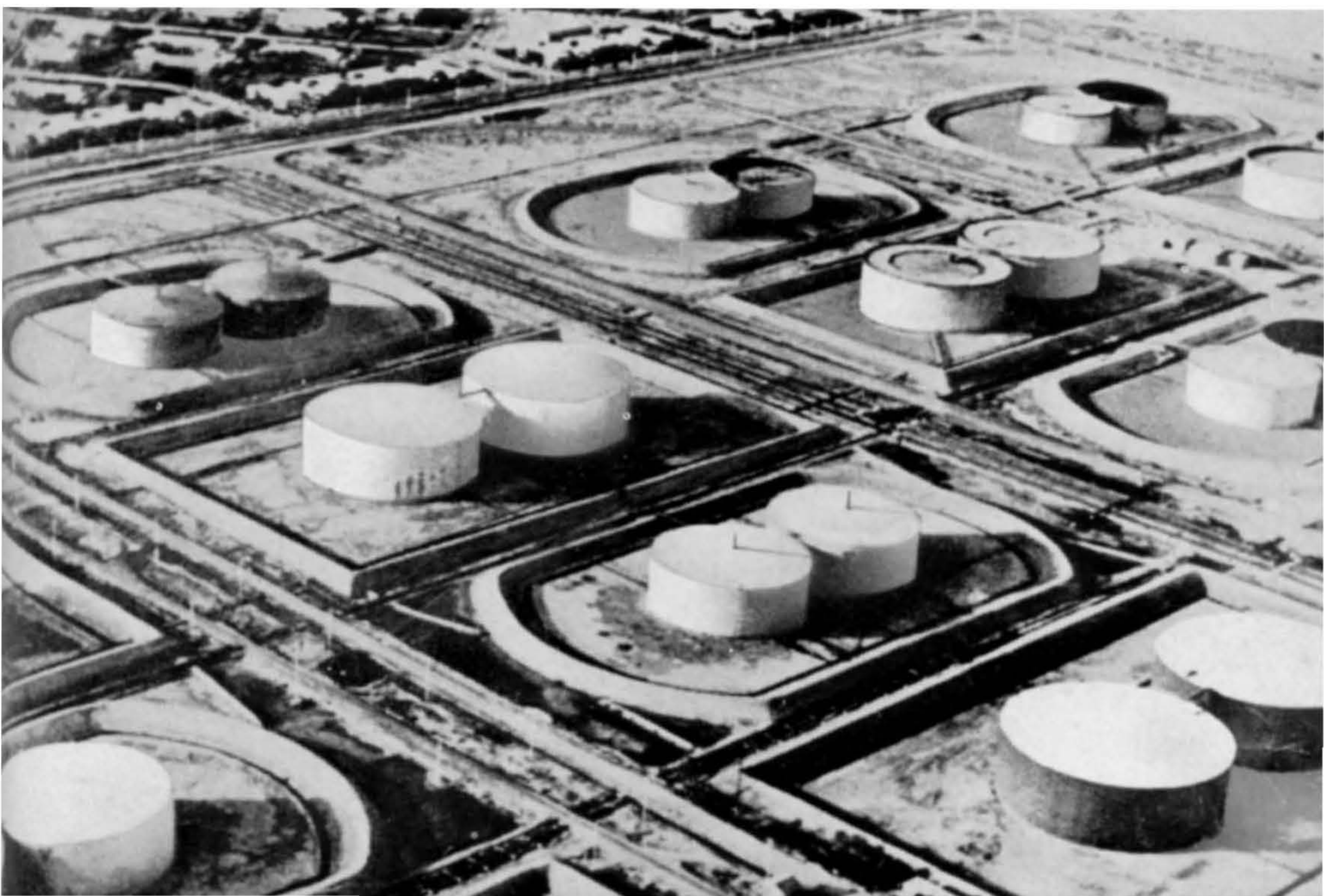
Tanklager der persischen Raffinerie Abadan. Weit auseinander gezogen, Tankgruben mit 100% Fassungsvermögen, breite Schneisen.
