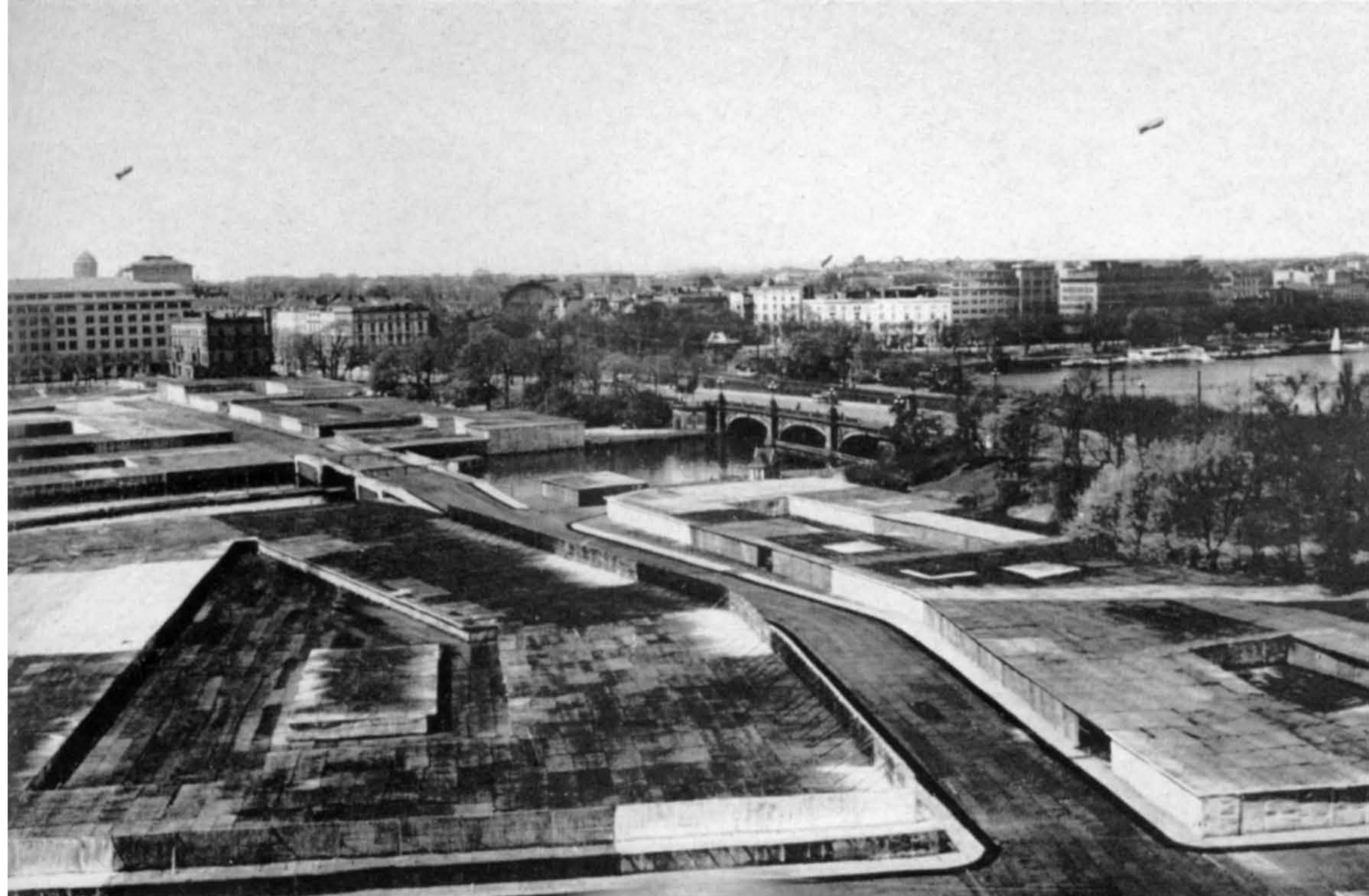
Binnenalstertarnung in Hamburg. Blick auf die Lombardsbrücke. Links davon eine künstliche zweite Lombardsbrücke. Im Hintergrund links das ‚Esso-Haus‘ – darüber ein Sperrballon.
