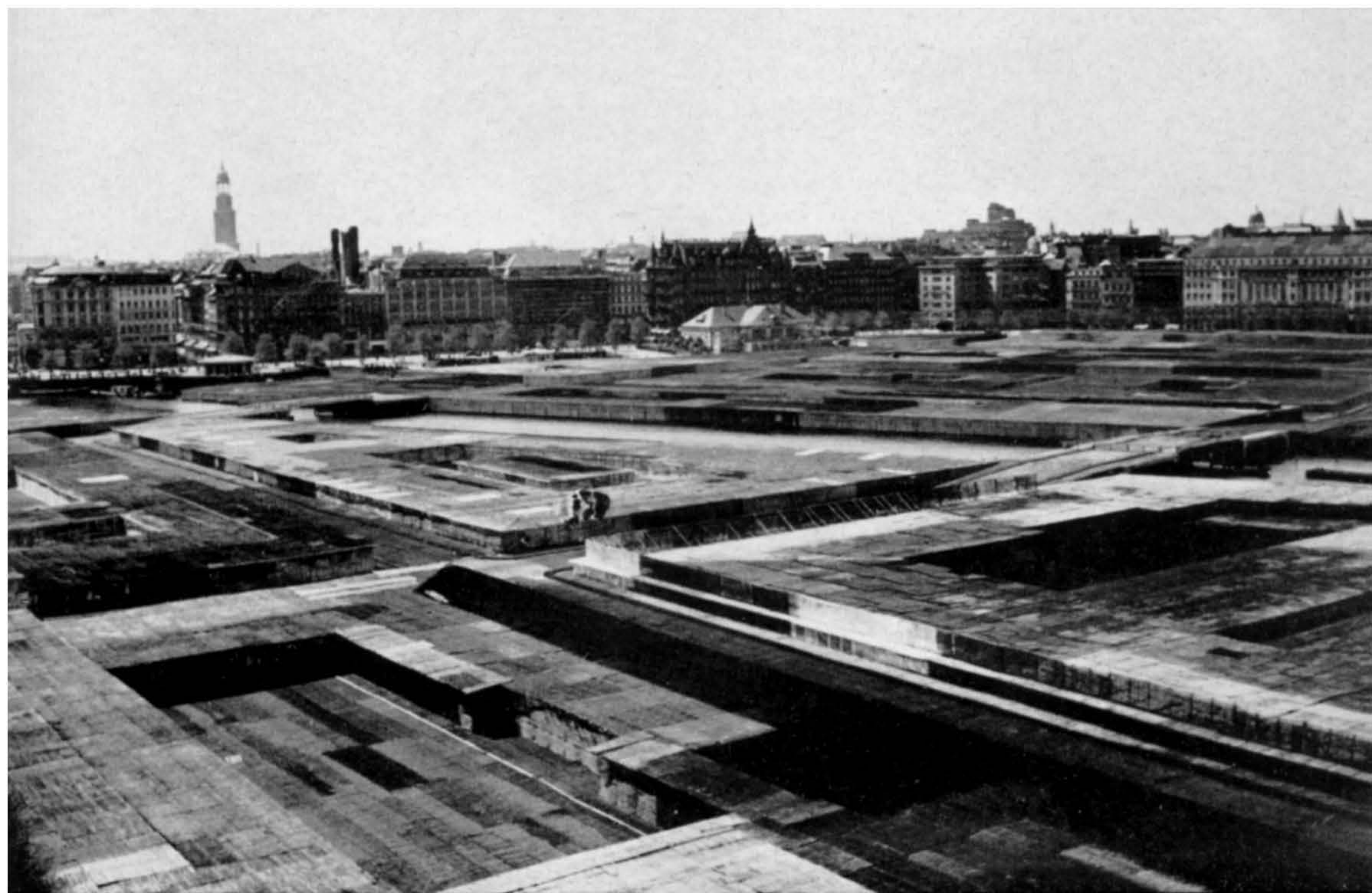
Binnenalstertarnung in Hamburg. Blick in Richtung Jungfernstieg. Im Hintergrund Bildmitte der Alsterpavillon, links der Turm der Michaeliskirche.
