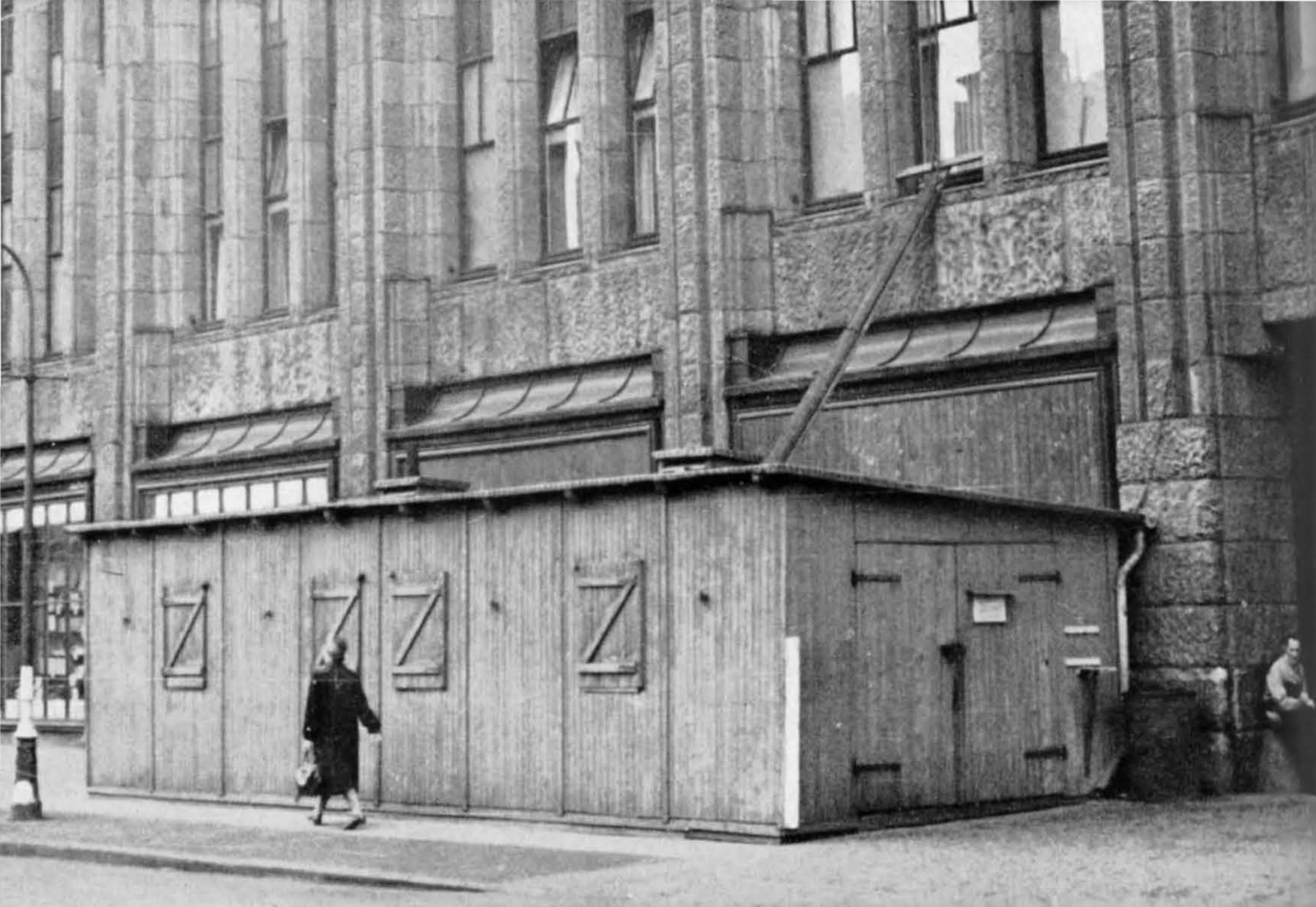
Flakbaracke, angebaut an das Hamburger Warenhaus Karstadt in der Rönnhaidstraße. Sie bildete den Brennpunkt für den weitausgreifenden Brand.
