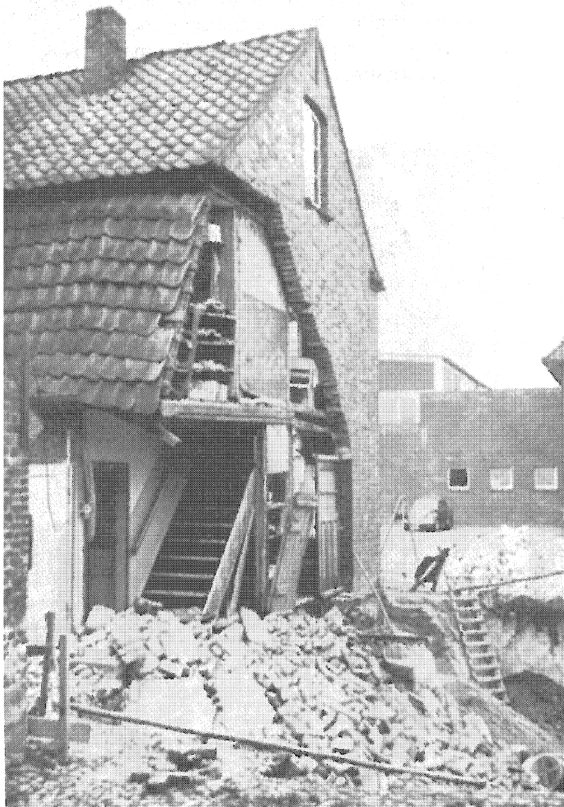
Gebäudeschaden durch Baugrundveränderung
