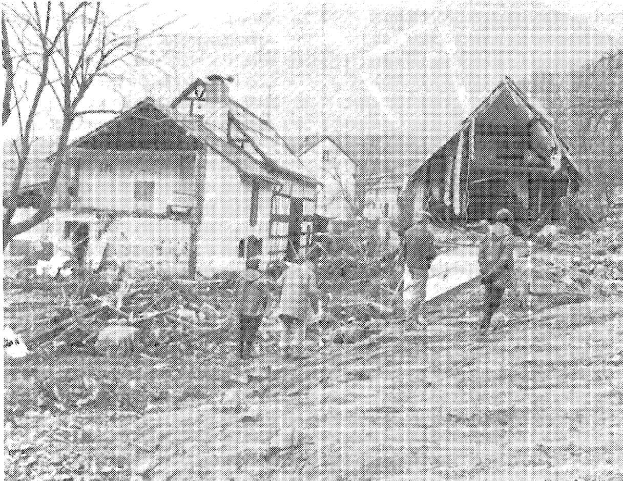
Gebäudeschäden nach einer Flutwelle
