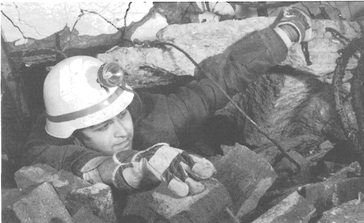
Ausnutzen der Hohlräume unter den Trümmern zur Herstellung des Kriechganges
