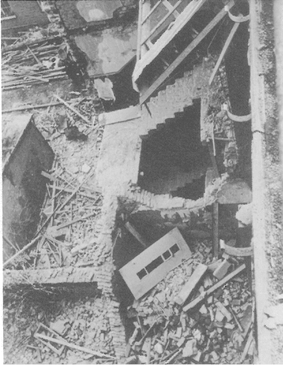
Mit kleinbrockigen Trümmerteilen verfüllter Raum
