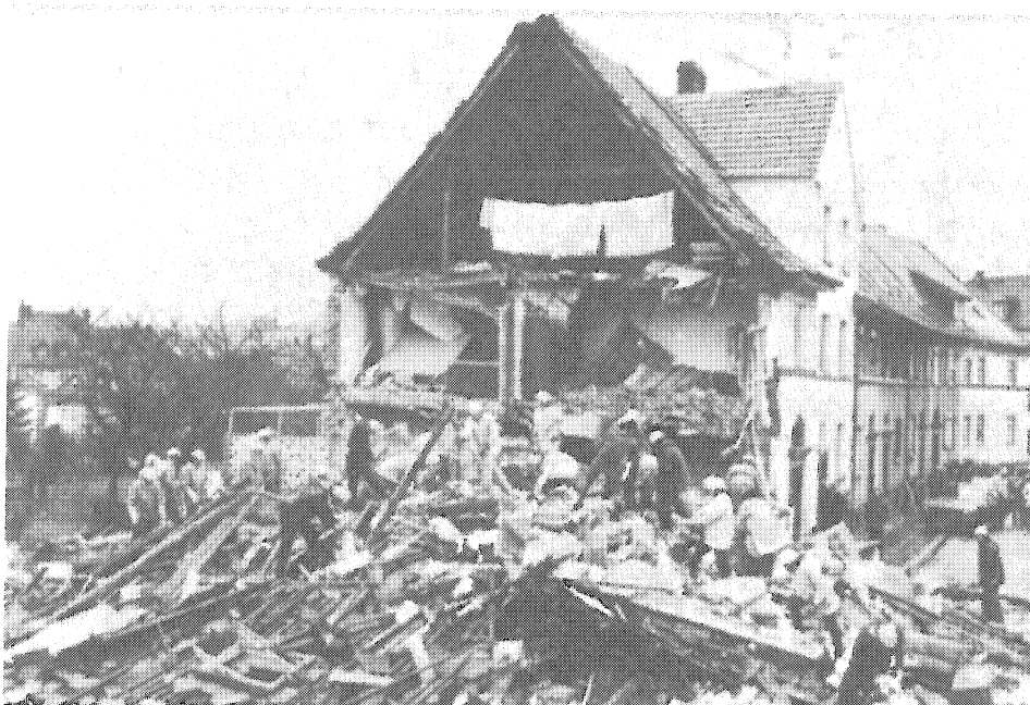
Gebäude nach einer Gasexplosion
