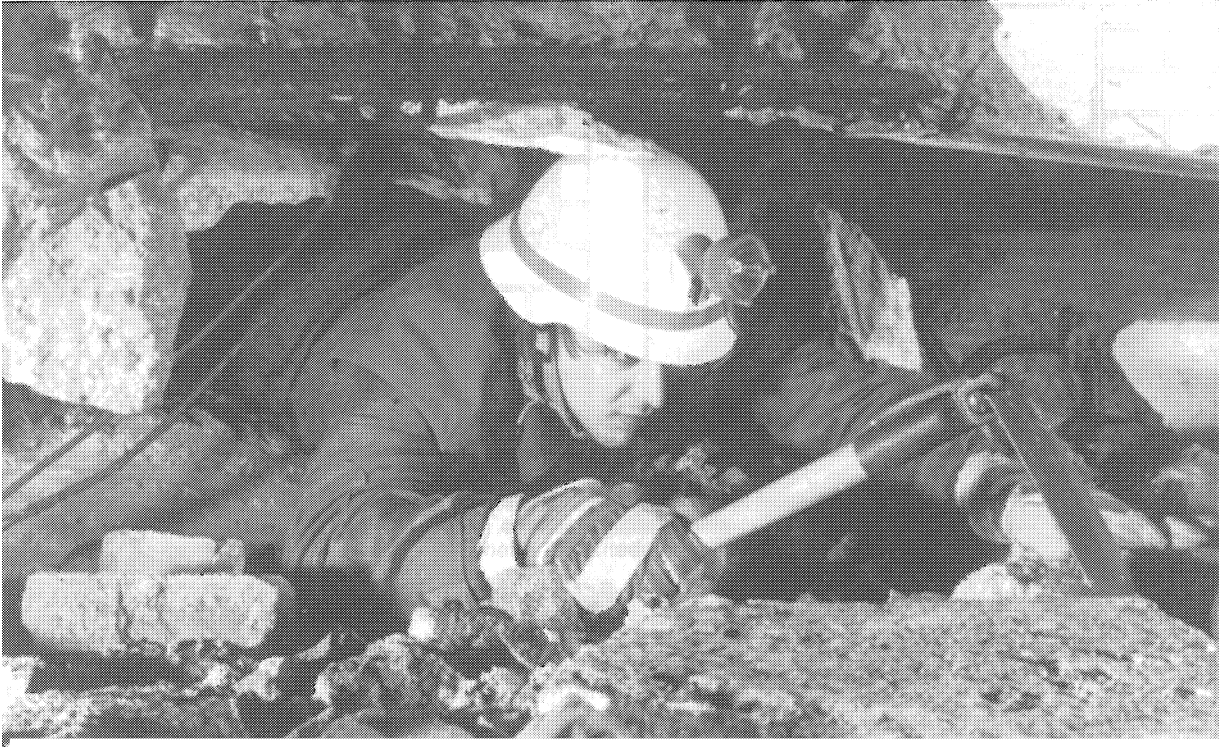
Vortrieb eines Kriechganges
