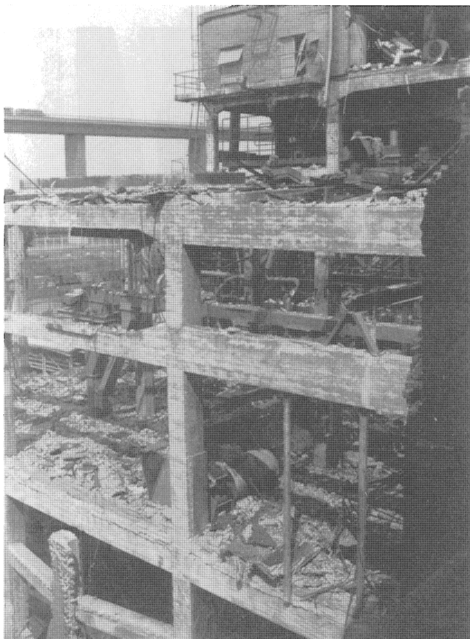
Stahlbeton-Skelettbau nach einer Gasexplosion im Inneren des Gebäudes
