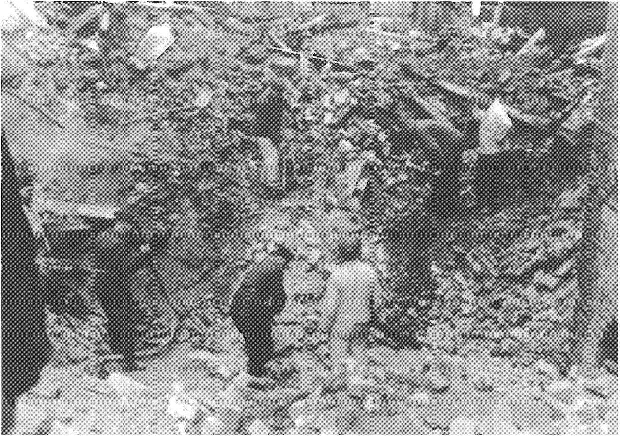
Freilegen des Zuganges eine Schutzraumes
