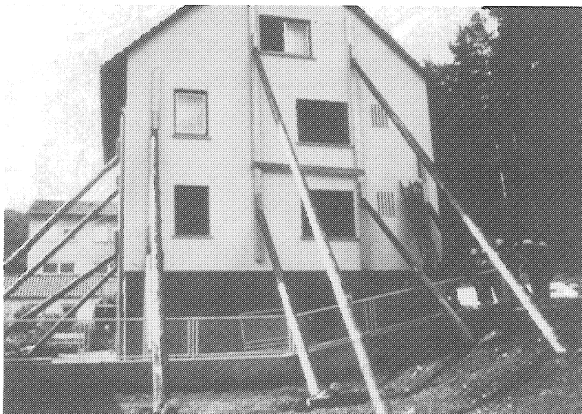
Angeschlagenes Gebäude infolge eines Erdbebens, das bis zur Instandsetzung abgestützt wurde
