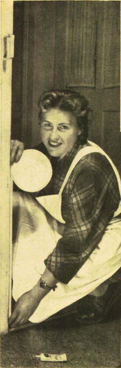
Schaumgummi dichtet ausgezeichnet , natürlich nicht in Versen. Aber Schaumgummistreifen, die sich elastisch in die Ritzen schmiegen, halten Zugluft ab, wenn man die Kanten undichter Türen und Fenster damit belegt. Türen lassen sich dann auch bei temperamentvoller Behandlung ganz leise schließen.
