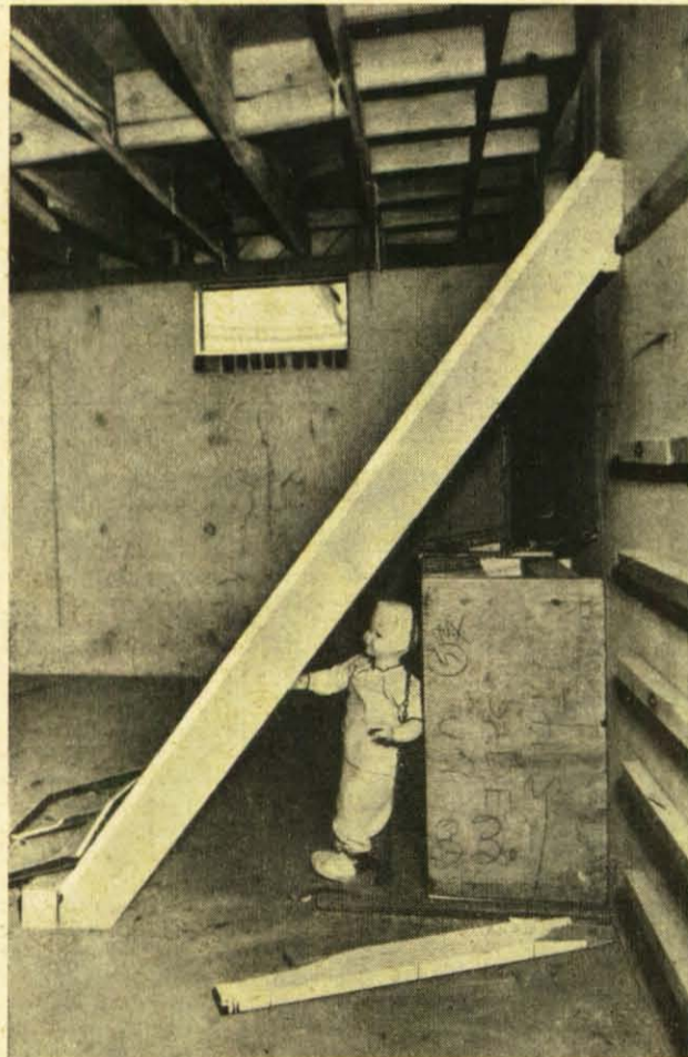
Der schräge Stützbalken verhinderte, daß die Wand eingedrückt wurde. Um die Wand die Kommode fiel um. Es ist eine Mansarde, in der sich im Ernstfall kein Mensch aufhalten würde, denn man ginge wenigstens in den Keller. Sie hat hier eine reine Versuchsbestimmung für Baufachleute.
