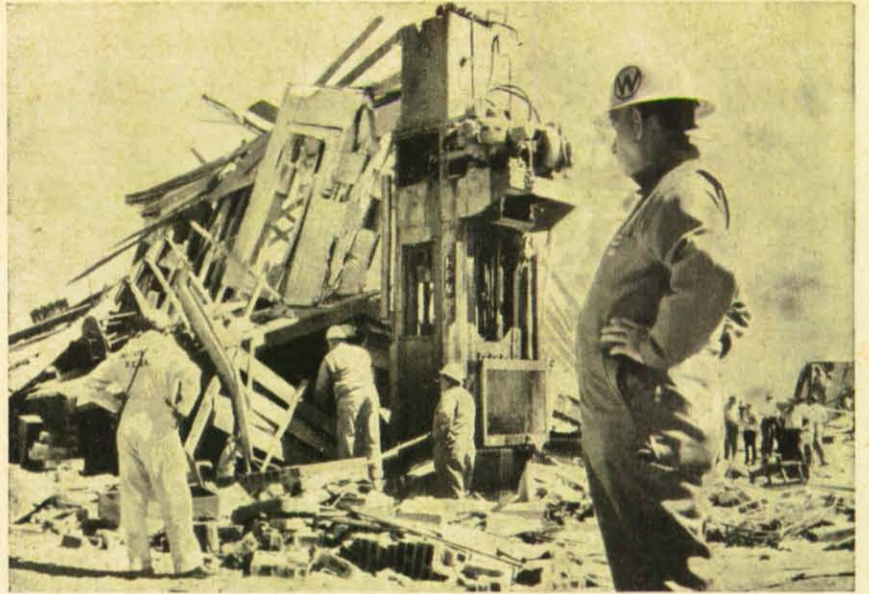
Das eine blieb stehen und das andere stürzte zusammen. Stehenblieb der stählerne Behälter auf der rechten Seite, ein Öltank, das Wohnhaus nebenan aber wurde schwer beschädigt. Der Unterschied zwischen der Luftdruckwirkung auf den Stahlbehälter und der auf das Haus aus Holz, Leichtplatten und Ziegeln ist frappant und lehrreich.
