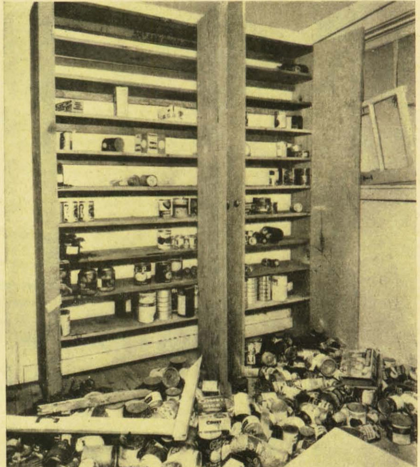
Auch die Lebensmittelvorräte gehören in den Schutzraum. Das beweist dieses Bild. Der Luftdruck schleuderte den größten Teil aus dem Schrank heraus, obgleich der Schrank selbst noch stehen blieb und auch bei den Fenstern nur die Scheiben eingedrückt sind. In einem modernen Schutzraum dürfen Lebensmittelvorräte nicht fehlen, weil man nötigenfalls in ihm stundenlang ausharren muß, bis die Radioaktivität abgeklungen ist.
