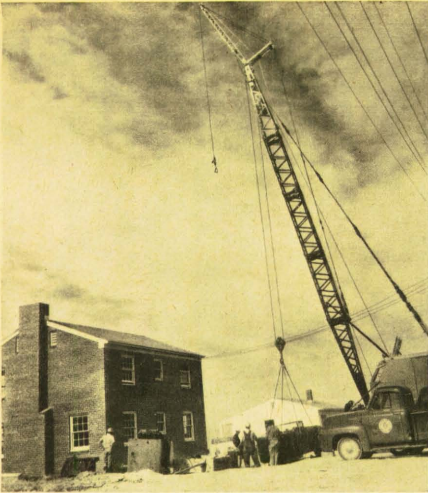
Aufbau der Geisterstadt aus Ziegelmauerwerk, Schlackenplatten und Holz, ein- und zweigeschossig im germanischen Wohnhausstil. Hochspannungsdrähte gehören genauso dazu wie 90 Zentimeter unter der Erde liegende Gas- und Wasserleitungen, für die der hohe Kran das Material abläßt. Der Wüstenboden ist sandig und die Sonne brennt heiß — eine wenig einladende Gegend für Menschen, die Besseres gewöhnt sind.
