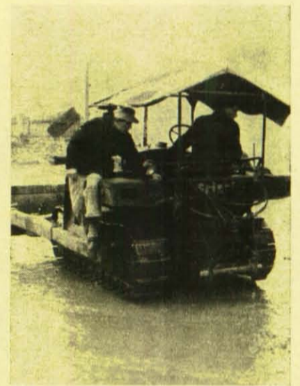
Räumgeräte wurden eingesetzt, um den Verkehr aufrechtzuerhalten und die Versorgung der Bevölkerung zu gewährleisten. Fotos: Dr. Fischer (2); Korenke (1).
