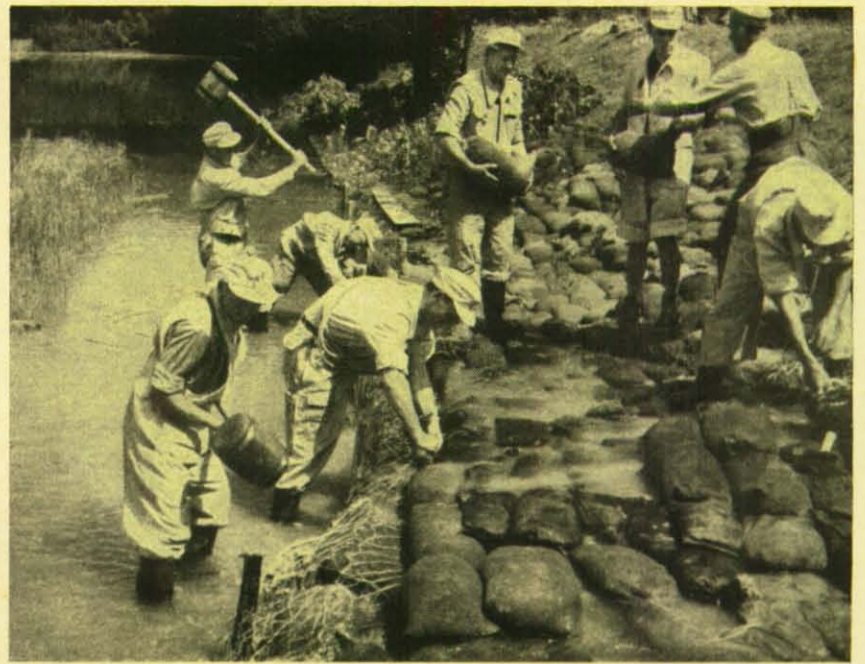
Der Damm ist in Gefahr! Viele Hände müssen zupacken, um eine Katastrophe zu verhindern, denn hinter dem Deich liegen fruchtbare Felder, Dörfer und Städte. Mit Sandsäcken und Faschinen werden die gefährdeten Stellen sachgemäß ausgebessert. Häufig muß der gleiche Abschnitt mehrmals verstärkt werden, denn wenn sich die gurgelnden Fluten erst einen Weg gegessen haben, ist es sehr schwer, sie aufzuhalten. Das Schlimmste scheint jedoch überstanden zu sein, denn die Männer des THW können wieder lachen.
