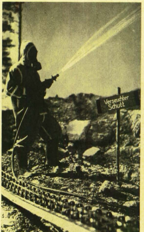
Der verseuchte Schutt wird mit Chlorkalk bestreut und dann mit Wasser übergossen, damit die Entgiftung tief in den Boden eindringen kann. Erst wenn unzählige Proben aus dem Erdreich untersucht sind, wird das geräumte Gebiet endgültig freigegeben.
