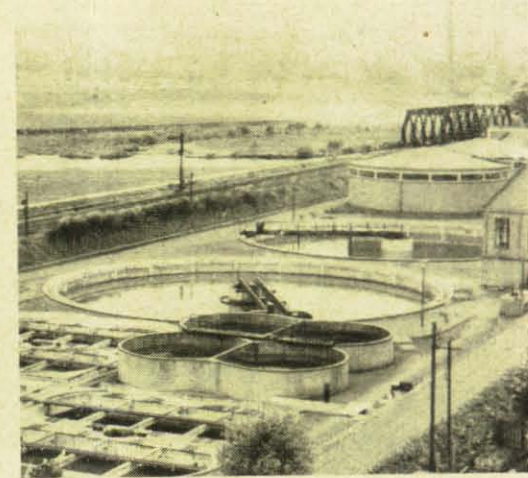
2 Millionen DM kostet eine solche Kläranlage, wie sie in Essen-Steele gebaut wurde. Sie ist ein Beweis dafür, daß der Mensch den Schmutz besiegen kann. Wir bräuchten noch ungefähr 700 solcher teurer Anlagen.
