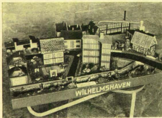
Einen Stadtteil in Wilhelmshaven zeigt dieses Modell. Es will die Entnahme von Löschwasser veranschaulichen. Aus einem Fluß wurde Wasser abgeleitet, um auch entfernte Häuserblocks löschen zu können.
