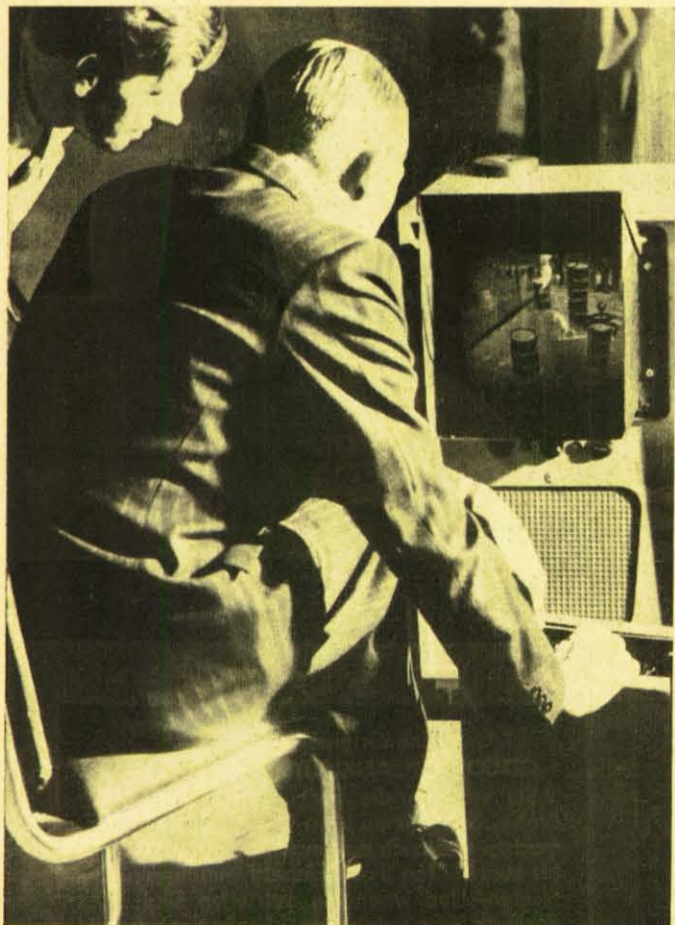
Fernseh-Regisseur, Operateur und Zuschauer ist dieser Kranführer in einer Person. Ohne das Fernauge am Arm seines Kranken könnte er in seiner Kabine nicht sehen, wohin sich die Greifer senken. Ein ideales Hilfsmittel für unübersichtliche Baustellen, an denen sonst eine zusätzliche Arbeitskraft erforderlich wäre, um den Kran- oder Baggerführer immer wieder umständlich und langwierig einzuweisen.
