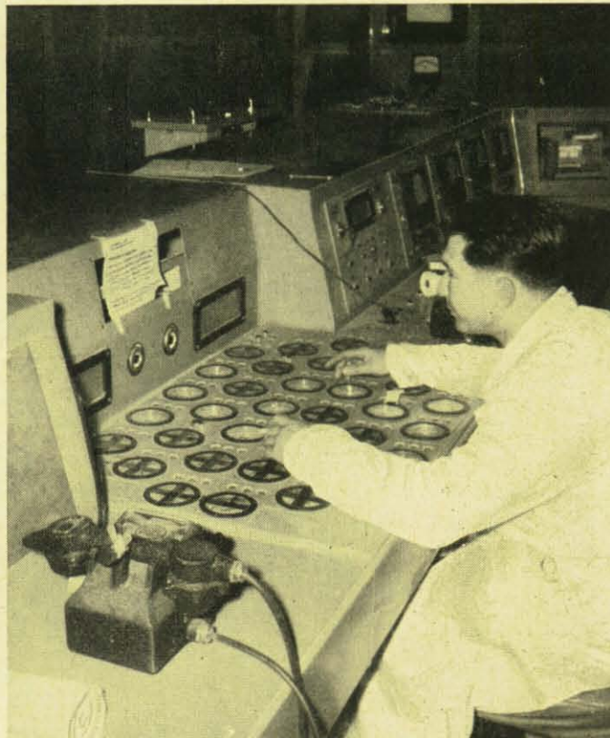
Tag und Nacht ist diese Kontrolltafel besetzt. Sie ist gewissermaßen das Gehirn des Werkes, denn hier können Energieschwankungen registriert und ausgeglichen werden. — Das G.-1-Werk, zu dem diese Tafel gehört, wird von mächtigen Turbinen mit Luft zur Abkühlung versorgt. Jedes Blaswerk — es sind vier vorhanden — liefert 70 Kubikmeter Luft in der Sekunde. Bei Berührung mit den im Reaktionsprozeß befindlichen Uranium-Barren steigt die Lufttemperatur um 300°.
