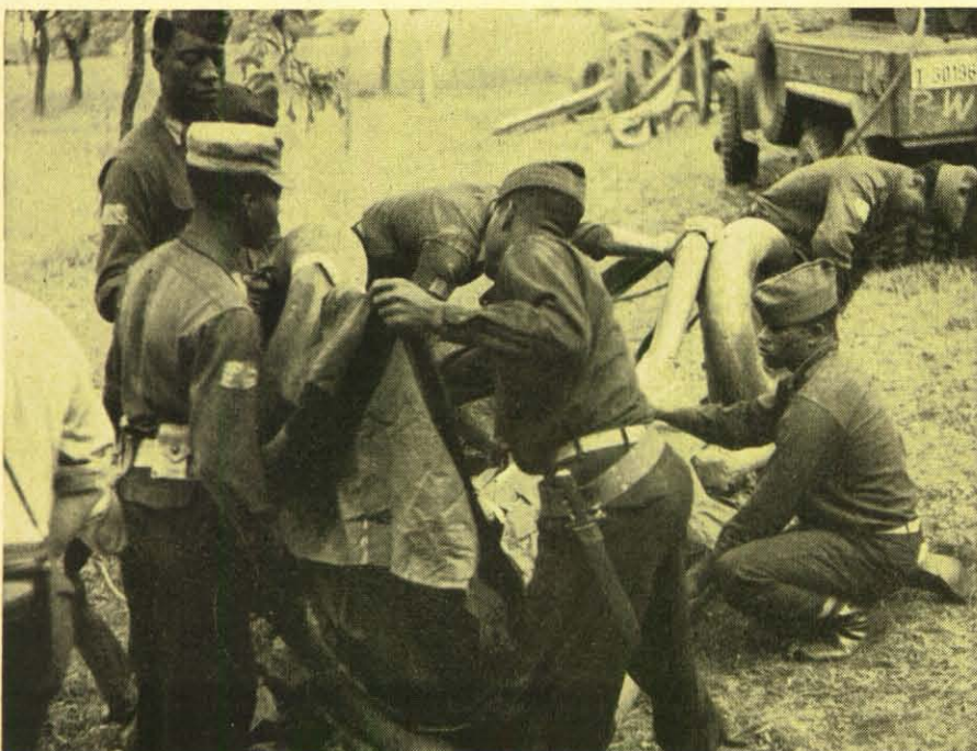
Vor dem Aufblasen... Ein langer Schlauch ist vom Lastwagen abgerollt. Das Druckluftgerät beginnt zu arbeiten. Die unformige graue Gummimasse nimmt langsam Gestalt an. Es ist ein Jeep, der hier aufgeblasen wird. Zwei Räder sind schon ganz deutlich erkennbar.
