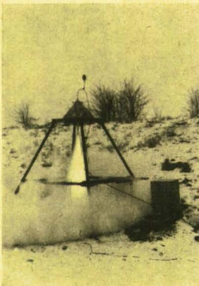
**Einen Wert von 2500,- DM** hat dieses kleine Stahlgerüst. Es ist ein Prüfstand für Raketenantriebsstoffe. Mit ihm wird die Schubkraft und die Brenndauer für Raketen erprobt. Die Antriebsmittel sind von entscheidender Bedeutung für die Flugbahn, aber auch für die Sicherheit der feinen und wertvollen Instrumente.
