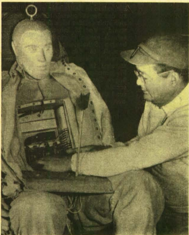
Einer letzten Überprüfung werden die Instrumente unterzogen. Sie sind in Kopf und Rumpf der Versuchspuppe eingebaut und ersetzen gewissermaßen die menschlichen Organe.
