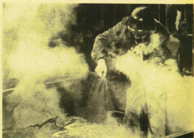
Ob Vollstrahl oder Sprühstrahl, immer vermag man mit der Einstellspritze Entstehungsbrände zu bekämpfen. Es kommt nur darauf an, daß man die Brandbekämpfung sofort richtig vornimmt.
