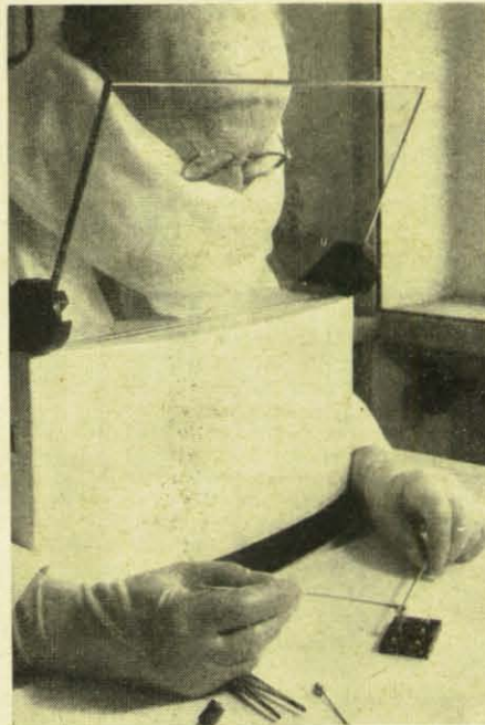
Vermummte Wissenschaftler arbeiten mit radioaktivem Kobalt. Eine Gazemaske vor Mund und Nase schützt sie vor der Einatmung umherfliegenden Kobaltstaubes. Ein Strahlenphysiker füllt das Kobalt in Plexiglasröhrchen, die später in eine Krebsgeschwulst eingeführt werden. Bleiwand und -glasscheibe halten den Strahleneinfluß ab.
