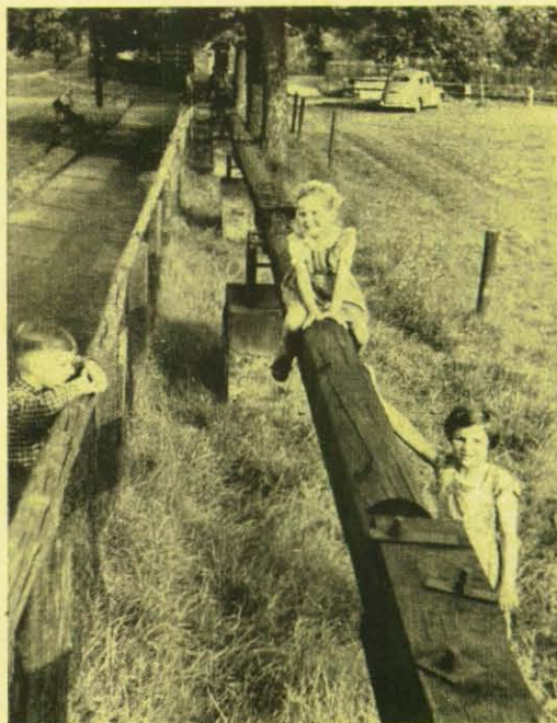
Die längste Kolbenstange der Welt ist aus vielen Stämmen zusammengefügt. Sie läuft auf Gleitrollen fast geräuschlos. Alle 15 Jahre muß sie erneuert werden. Sie wiegt wie das große Wasserrad insgesamt 450 Zentner. Auf der langen Strecke von fast 900 Metern hat sie nur einen Kraftverlust von rd. 10%.
