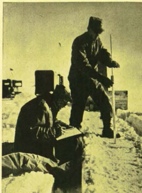
Wissenschaftliches Personal des US-Pionierkorps führt auf Grönland mit hochempfindlichen Spezialgeräten Messungen durch, um die Härte des Schnees festzustellen. Aus ihr wiederum läßt sich die Tragfähigkeit der Schneedecke bestimmen. In vielen Teilen Grönlands fallen jährlich 90 cm Neuschnee, der nie schmilzt.
