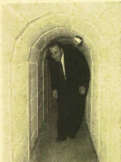
Leicht gebückt , aber lächelnd sucht der Herr den Weg ins Freie. Dieser waagerechte Notausstieg wurde aus vorgefertigten Stahlbetoneinzelteilen zusammengefügt.
