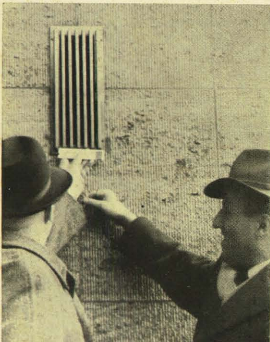
Als ornamentaler Schmuck der Fassade kann ein Luftschacht — wie hier — wirken.
