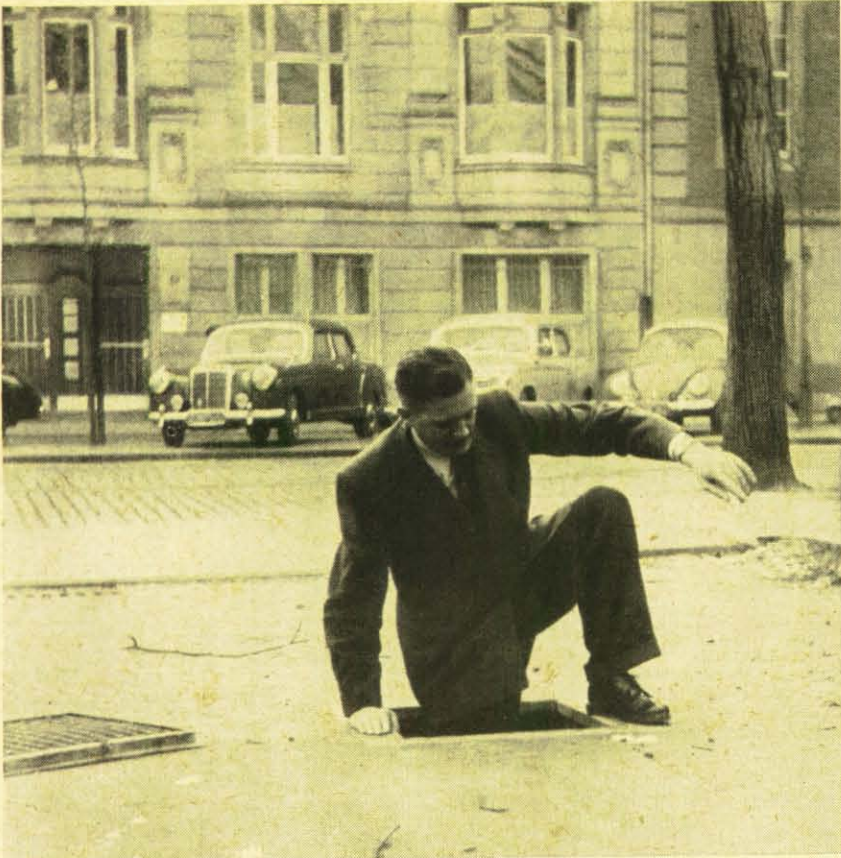
Aus der Unterwelt , aus einem Loch auf der Düsseldorfer Haroldstraße, steigt plötzlich ein Herr ans Tageslicht. Woher kommt der Mann? Aus der Kanalisation? Nein, er begibt probeweise den Notauslaß eines Schutzraumes. Der Ausstieg liegt zwanzig Meter vom Gebäude entfernt. Das ist notwendig, denn Trümmer dürfen ihn nicht verschütten.
