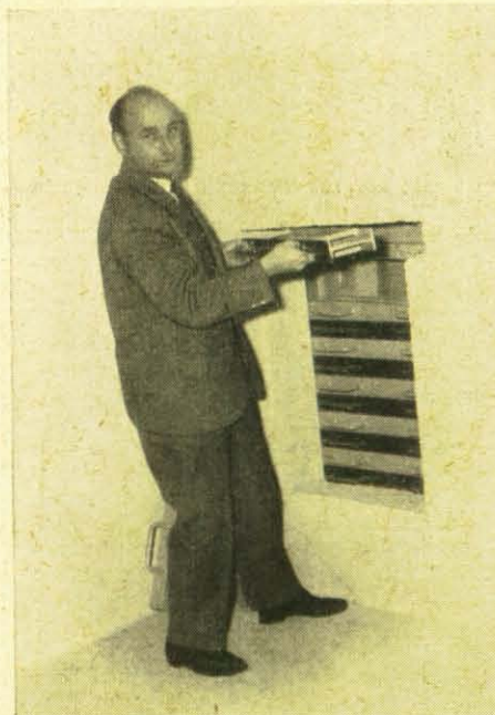
Wenn Treppe und Notauslaß zerstört sind, können die Insassen noch durch diesen „Trägerverschluß“ den Schutzraum verlassen. Die in zwei seitlichen Schienen eingescho-benen Träger werden Stück für Stück herausgehoben, und der Weg ist frei. Im Ernstfall bedeutet dies Rettung für viele Menschen.
