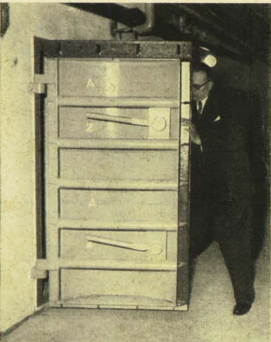
Eine Atombomben-Druckwelle von 10 atü hält diese neuartige Drucktür spielend aus. Sie wiegt 600 Kilogramm und verschließt den Eingang zum Schutzraum eines Ministeriums in Düssel- dorf, der nach neuesten Erfahrungen erbaut ist.
