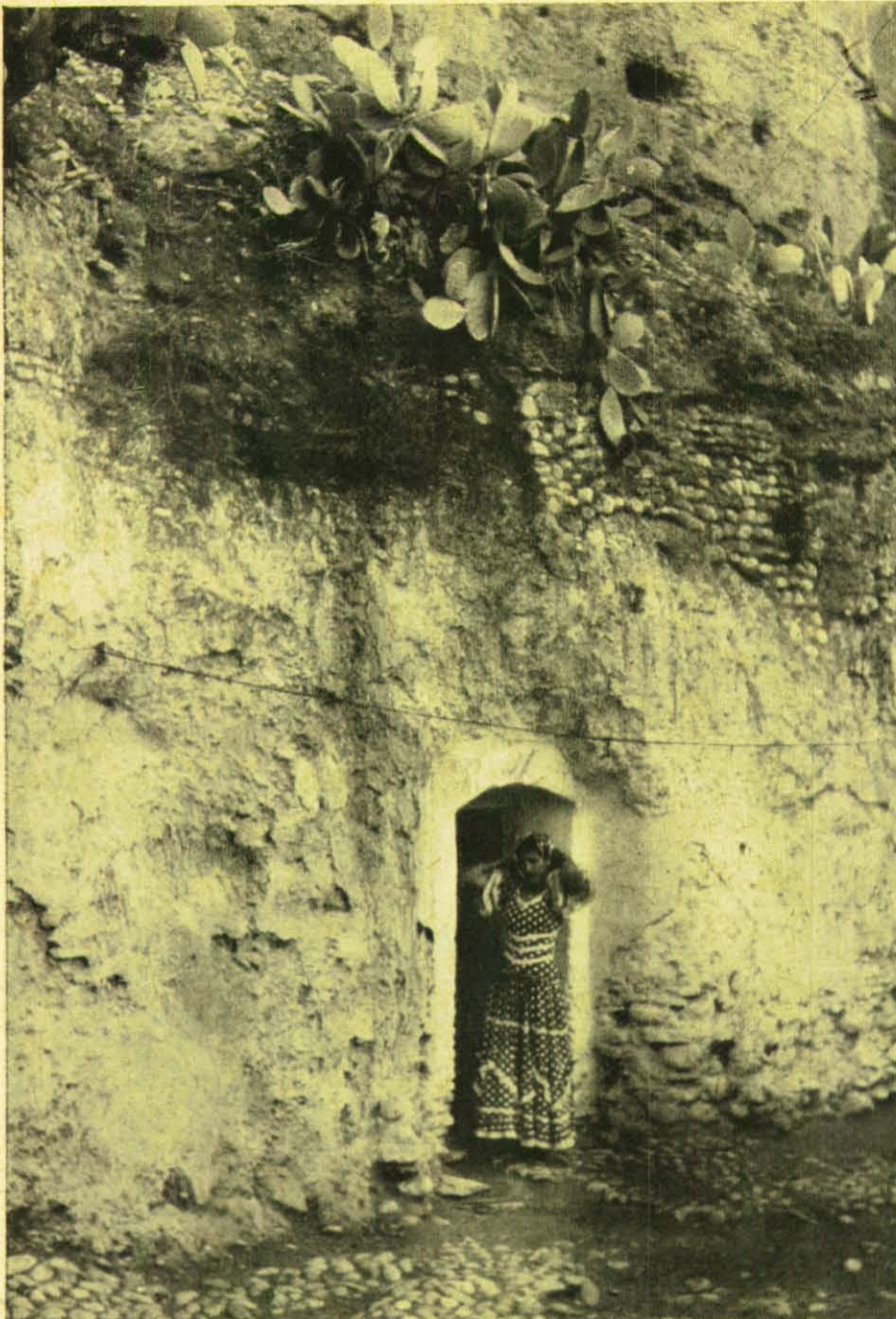
In den Fels gehauene Höhlenwohnungen sind auch heute noch in gebirgigen und heißen Ländern eine durchaus zweckmäßige und übliche Wohnform. Diese Wohnhöhlen sind sehr dauerhaft und bieten außerdem noch Schutz gegen Hitze und sonstige Witterungsschäden. Unser Bild zeigt den Eingang zu einer dieser Wohnungen, wie sie in Andalusien zu finden sind. Sie werden von Zigeunern bewohnt.
