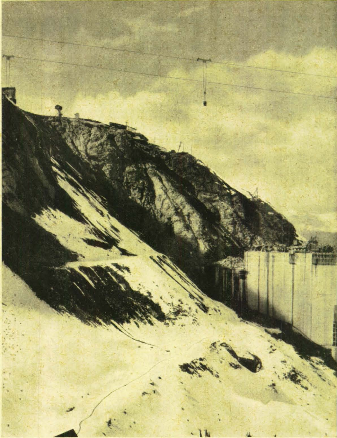
Nachschub für „Grande Dixence“ bringen die modernen Materialbahnen aus dem Tal. Obschon ein Teil der notwendigen Baumaterialien an Ort und Stelle gewonnen werden, sind die Bahnen ununterbrochen in Betrieb, um die Hilfsstoffe heranzuschaffen.
