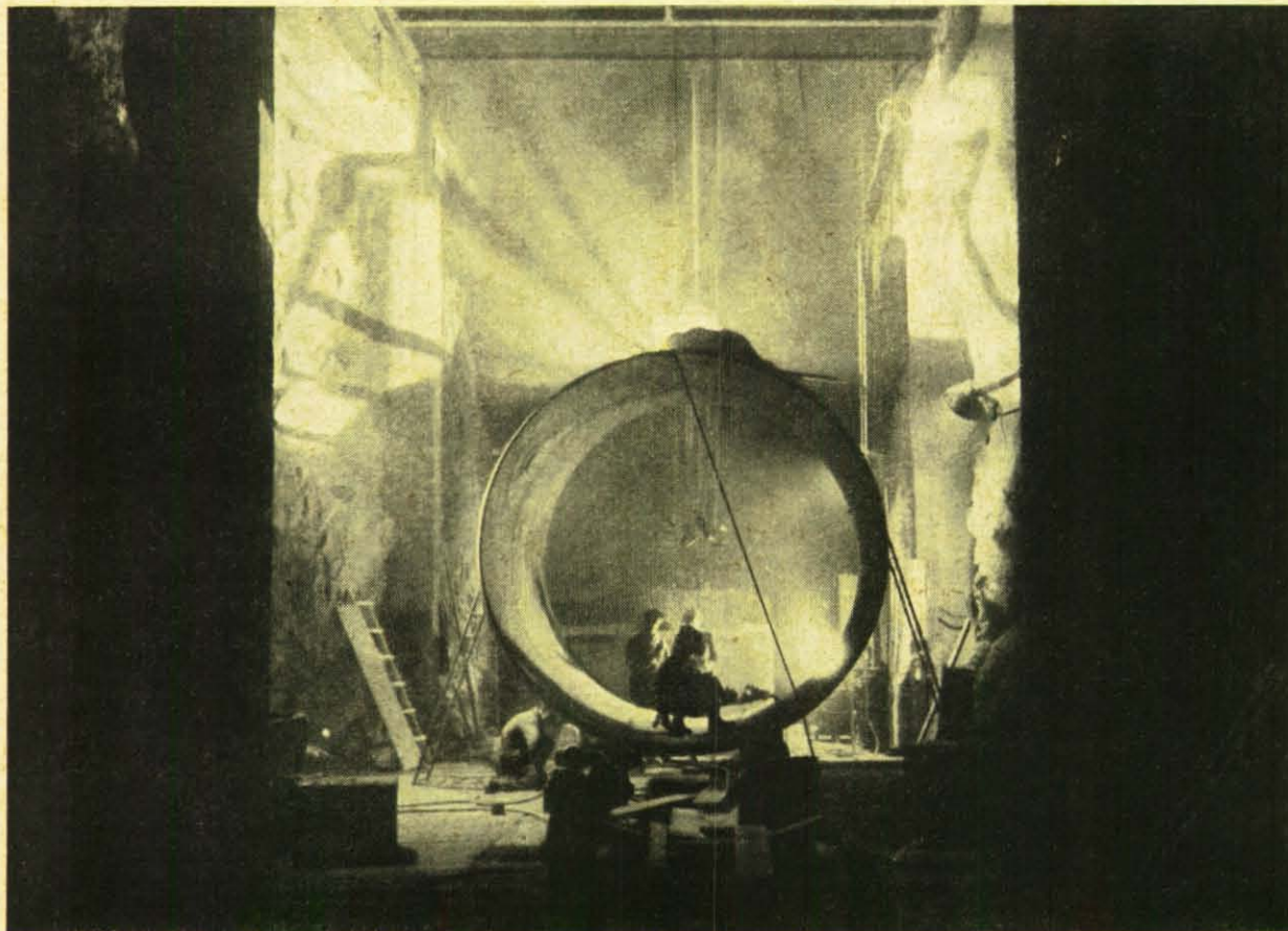
In die „Unterwelt“ des Dix-Tals im Schweizer Kanton Wallis führt uns dieses Bild. Es zeigt die Montage eines gewaltigen Druckrohres. Stollen in einer Gesamtlänge von über 120 km werden durch die Felsmassive getrieben. Oft können die Tunnel nur einen halben Meter am Tage weitergeführt werden, weil wandernde Moränen die Arbeit sehr beeinträchtigen.
