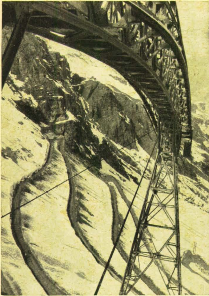
Nachschub für „Grande Dixence“ bringen die modernen Materialbahnen aus dem Tal. Obschon ein Teil der notwendigen Baumaterialien an Ort und Stelle gewonnen werden, sind die Bahnen ununterbrochen in Betrieb, um die Hilfsstoffe heranzuschaffen.
