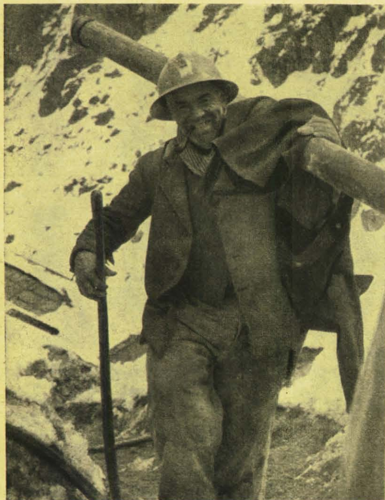
„Auf ein Neues“ sagen die Männer, und lachend packen sie fest zu. Der Bau des Staudamm-Giganten ist ein hohes Lied auf den unbekanntten Arbeiter, der jahrelang trotz Schnee und Eis in 2100 m Höhe sein Bestes tut. Über 30 Tote hat der Damm, haben die Sprengungen und Tunnelarbeiten bisher gefordert.
