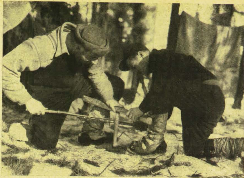
Feuer machen ohne Streichhölzer? Auch das muß gekonnt sein. Bill und Garry basteln sich einen Feuerbohrer, wie ihn die Menschen der Steinzeit verwendet haben. Durch Hinundherziehen des Bogenschaftes lassen sie die geschnitzte Spindel so lange rotieren, bis der Zunder Feuer fängt.
