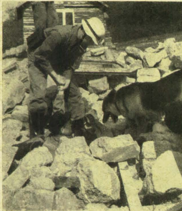
◀ Asta muß auch jetzt dabeisein. Geradezu stolz verfolgt sie die Arbeiten der Mannschaft. Es kann ihr nicht schnell genug gehen. Inzwischen werden alle Vorbereitungen getroffen, um die Geborgenen schnell abzutransportieren. Auch Erste Hilfe müssen diese Männer sofort leisten.
