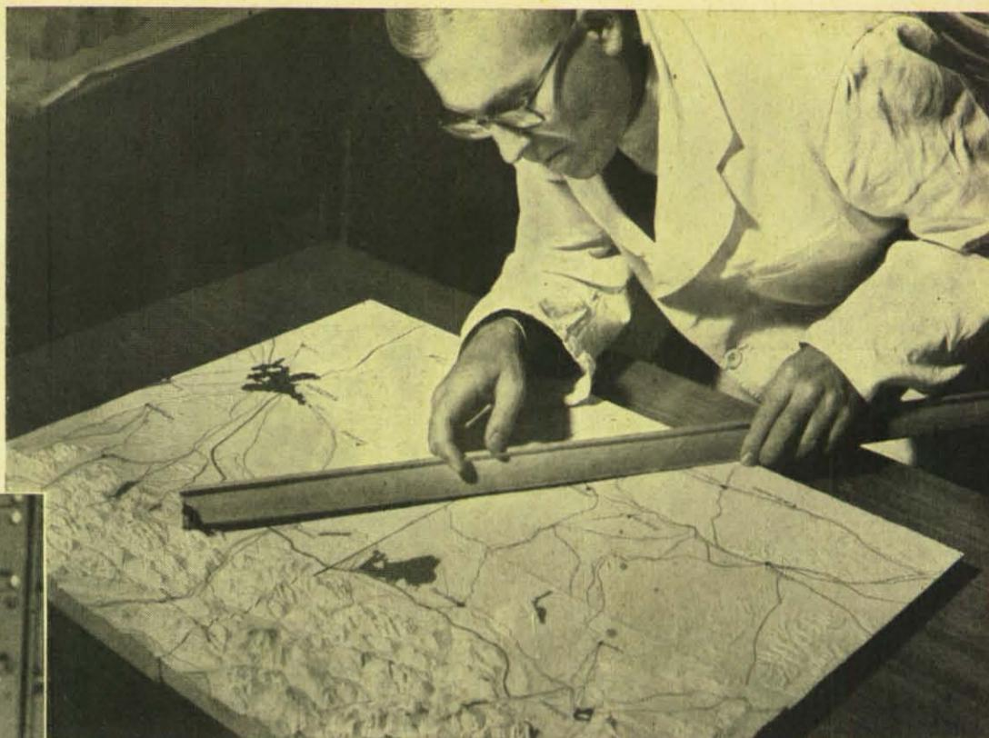
▲ **Gipsreliefs** von ganz Deutschland hat Dipl.-Ing. Hopf in seinem Schrank. Er ist verantwortlich für die richtige Aufstellung von UKW-Sendern. Mit einem nach der Erdkrümmung gebogenen Lineal prüft er, wo ein geplanter Sender am besten aufgestellt wird, um möglichst weit ins Land auszustrahlen.
