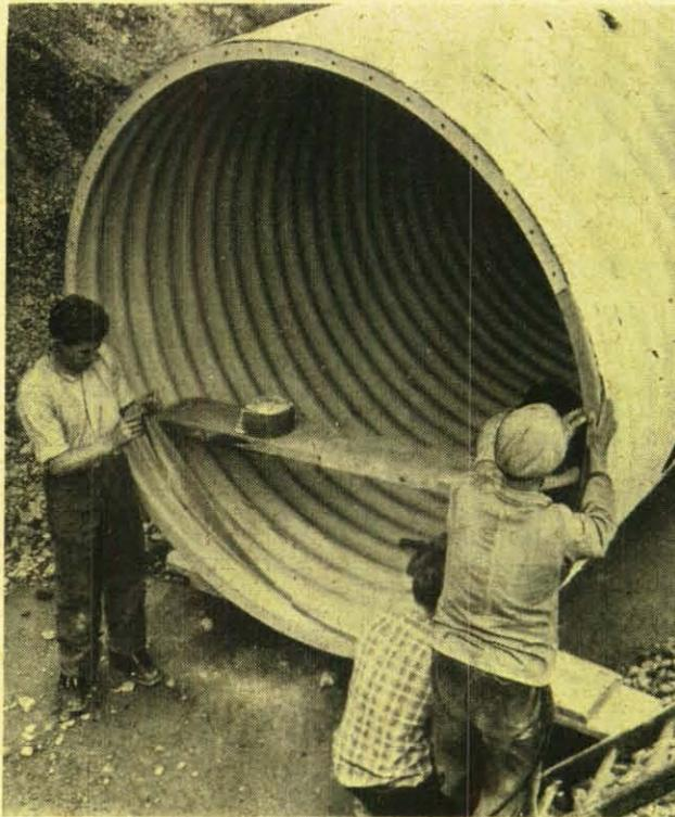
Wie ein unterirdischer Tunnel sieht diese Stahlröhre aus. Aber in ihr würden sich einmal Menschen längere Zeit aufhalten bereits, wenn Luftgefahr vorhanden wäre. Die Stahlwandung ist bereits bei der Herstellung gut isoliert worden. Nun muß sie noch ihre Betonumhüllung und eine Erdüberdeckung erhalten.
