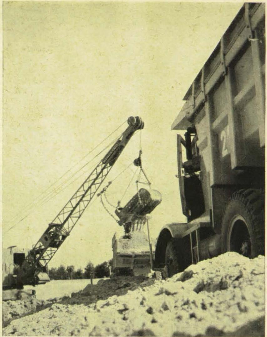
**Dreißig Kipp-Lastwagen** befördern die Erdmassen, die im Rahmen des Bauprogramms bewegt werden müssen. Das entstehende Wasserbecken wird 3,3 Millionen cbm haben. Ein wesentlicher Faktor unterscheidet Geesthacht von anderen Stauseen, außer der Besonderheit seiner Arbeitsweise. Das Becken wird nicht wie meist in den Felsen gesprengt, sondern in den Sand gegraben.
