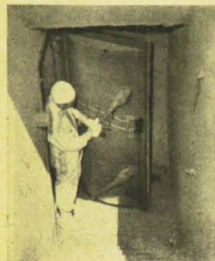
Gut überstanden hat auch diese schwere Schutzraumtüre den Atombombenversuch. Nach wie vor kann man sie mit Leichtigkeit öffnen und wieder schließen.
