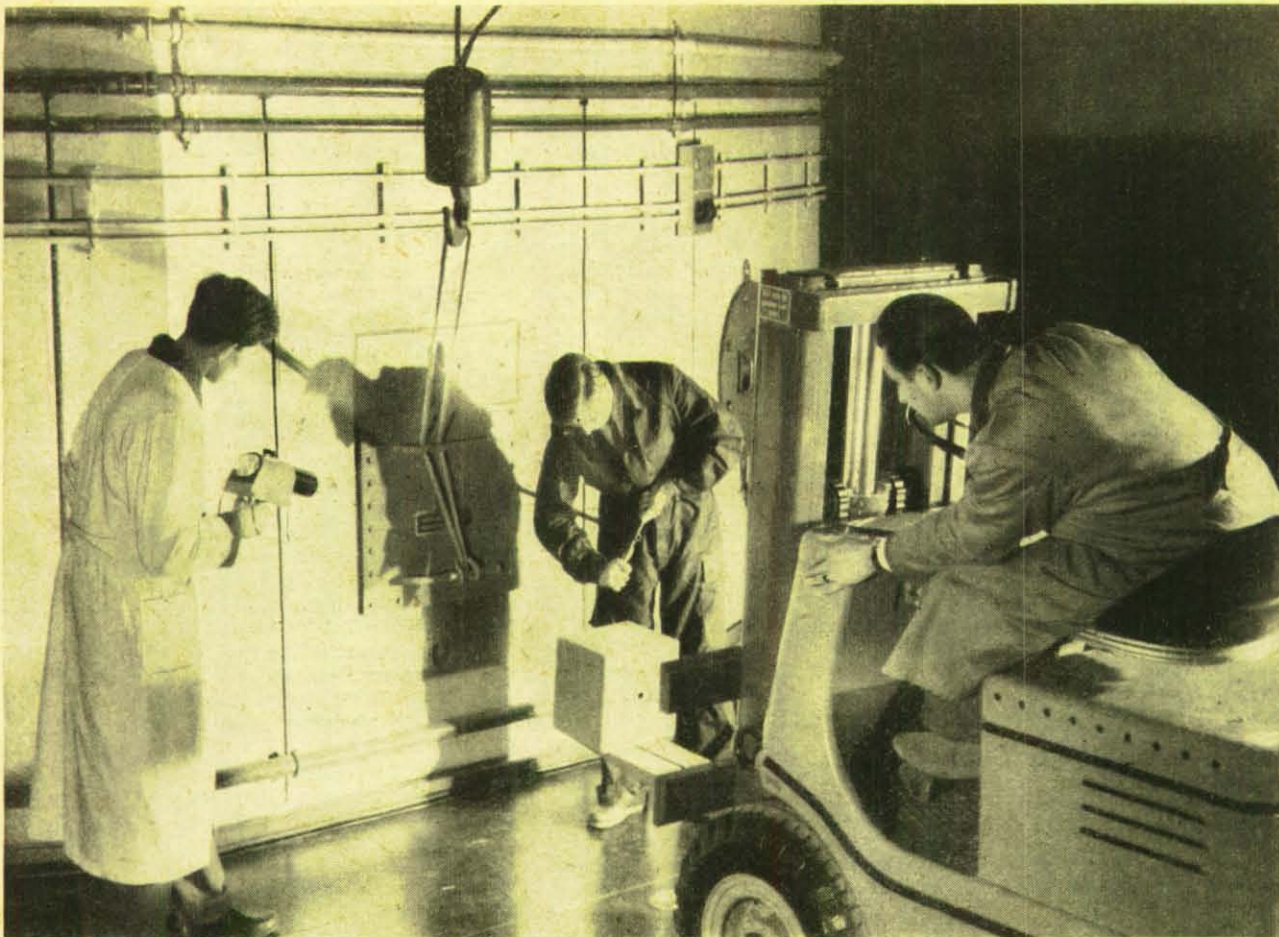
Der Strahlungsabschirmung dienen fast alle Sicherheitsvorkehrungen in einem Atomreaktor. Unser Bild zeigt die Bleiklötze, mit denen die Stahlverschlüsse der Beschickungsrohre umbaut werden — eine zusätzliche Sicherung. Oben das internationale Warnzeichen vor Radioaktivität.
