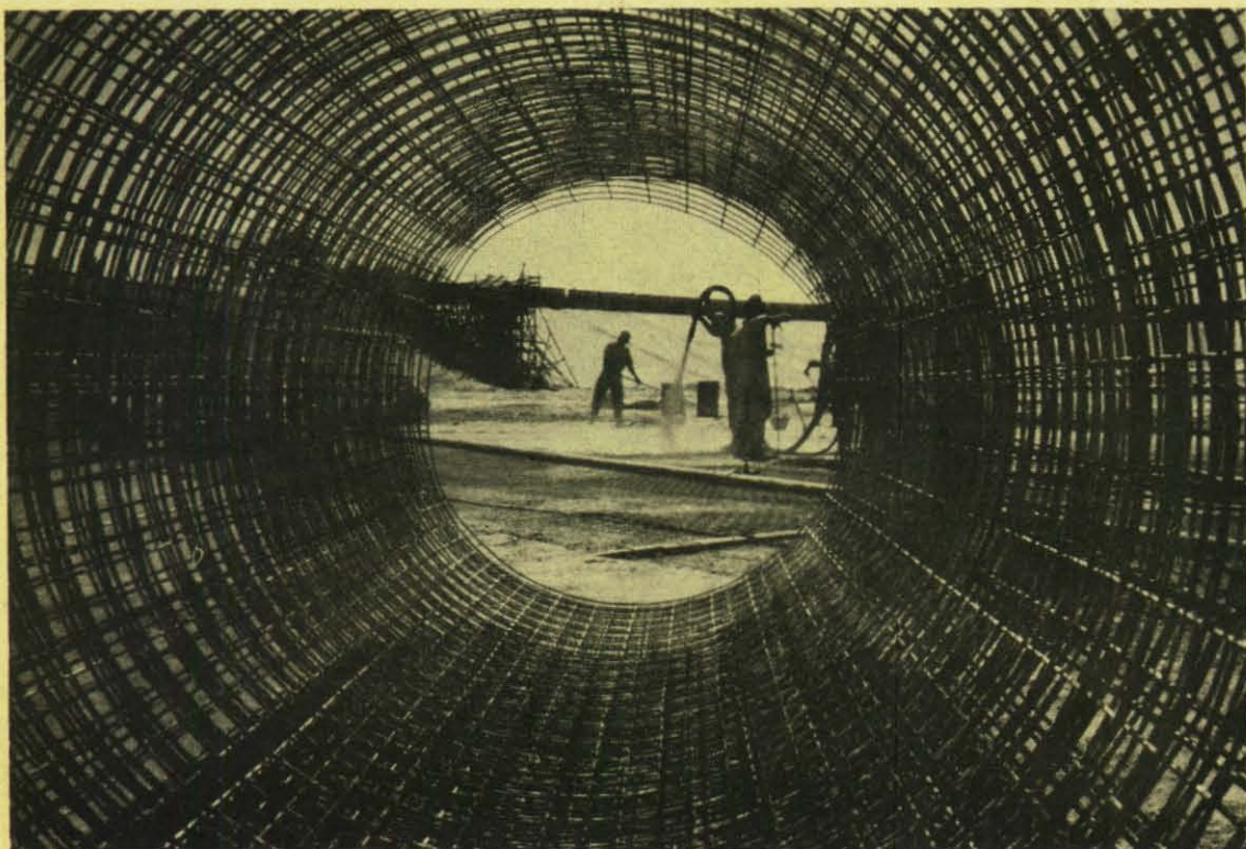
◀ Eine Kostbarkeit ist das Wasser in großen Teilen Israels. Deshalb wird alles getan, um an vielen Stellen neue Wasserreservoir zu errichten. Unser Bild zeigt das Drahtgeflecht eines riesigen Leitungsrohres. Tag und Nacht wird gearbeitet.
