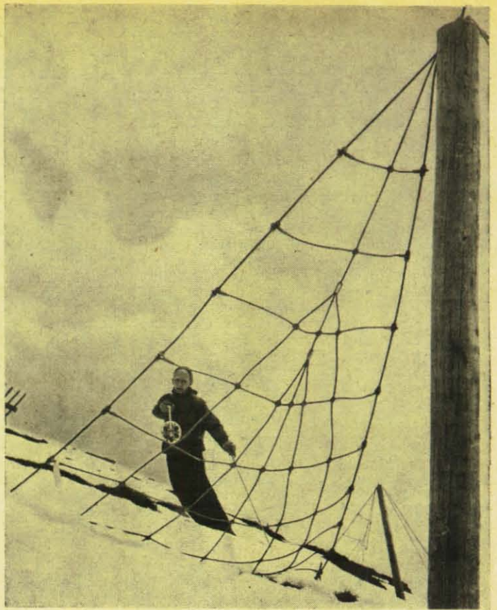
Immer neue Schutzmöglichkeiten werden erprobt, um die drohenden Gefahren eines jeden Winters abzuschwächen. Im vergangenen Jahr hat man zum ersten Male Kabelnetze als Stützflächen in die Lawinenverbauungen eingesetzt. Sie haben sich bestens bewährt und manche Lawine aufgehalten.
